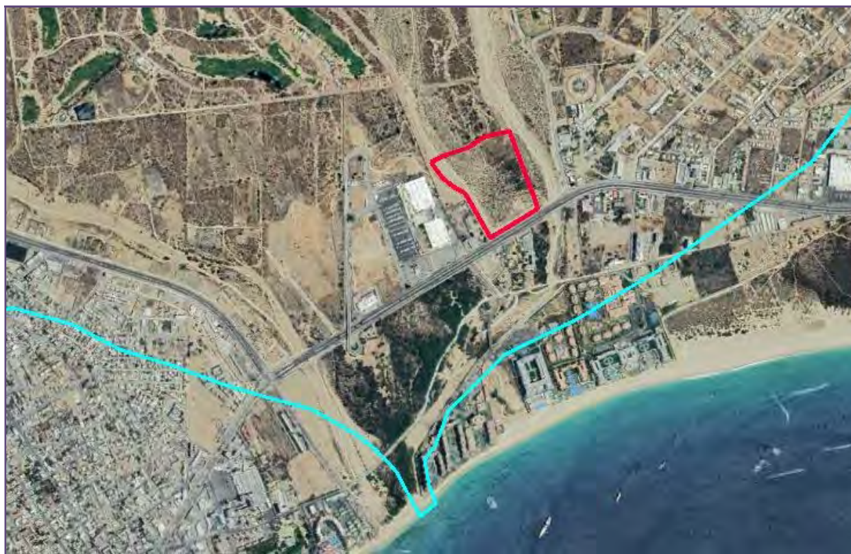
Figura 11.- Imagen de satélite de Google Earth donde es posible observar la construcción de desarrollo turísticos en la franja inmediata a la línea de costa.
