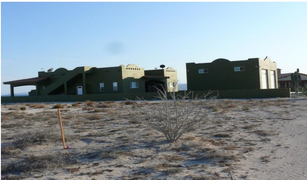
Figura 7. Construcciones habitacionales en los alrededores de la zona del sitio del proyecto propuesto.
