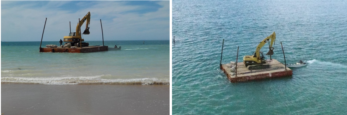
Ejemplo de traslado de excavadora en plataforma flotante.
