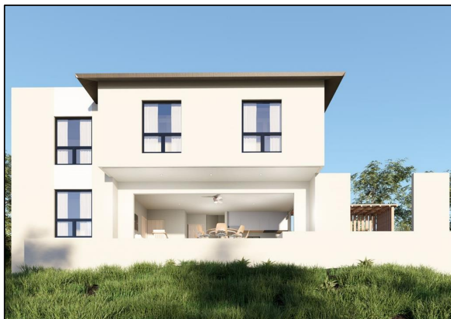
Figura II.1.3.10. Vista Frontal de la casa.
