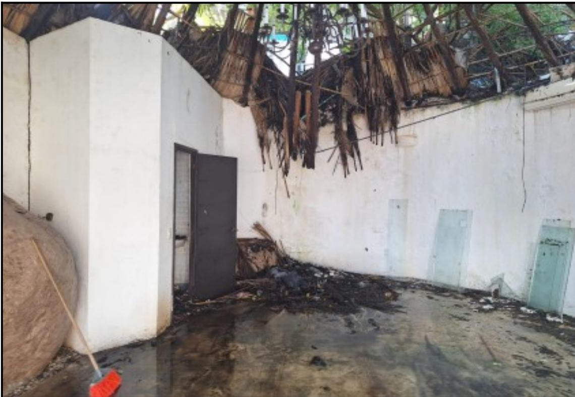
*Evidencia fotográfica actual donde se muestra el interior de la estructura existente donde será realizado el proyecto, observándose paredes blancas y techo de palma (palapa) parcialmente quemado. Asimismo, se observan daños en la parte superior y escombros en el suelo, en proceso de limpieza.*
