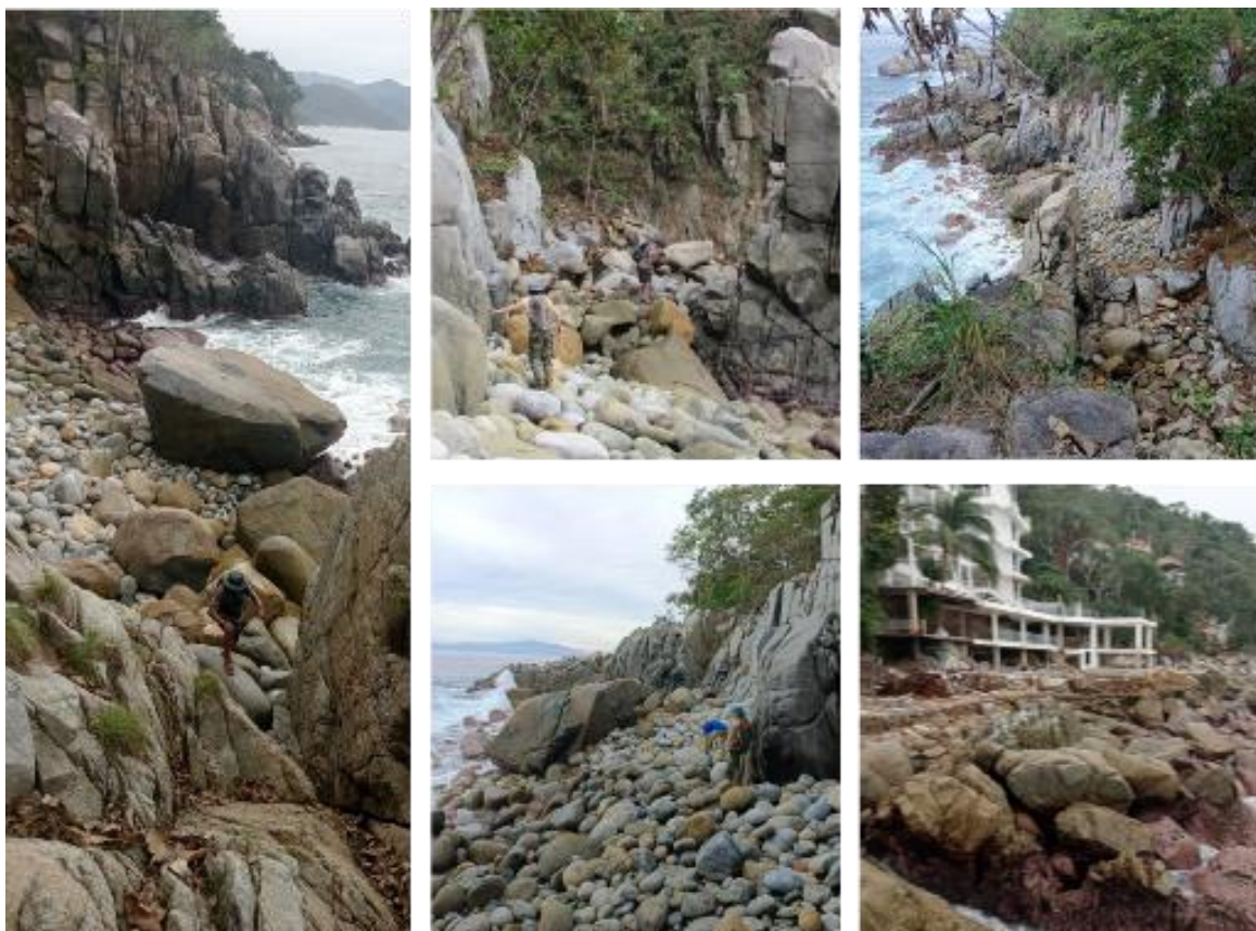
Figura II-11 Condiciones de la ZFMT del proyecto, donde se pretenden realizar las adecuaciones del litoral para la instalación de playas artificiales
