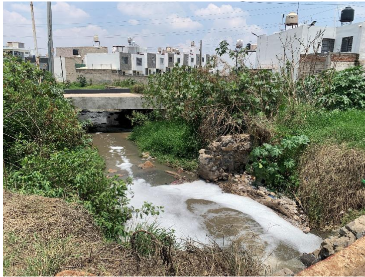
Figura. Evidencia fotográfica del estado Actual del sitio del proyecto
