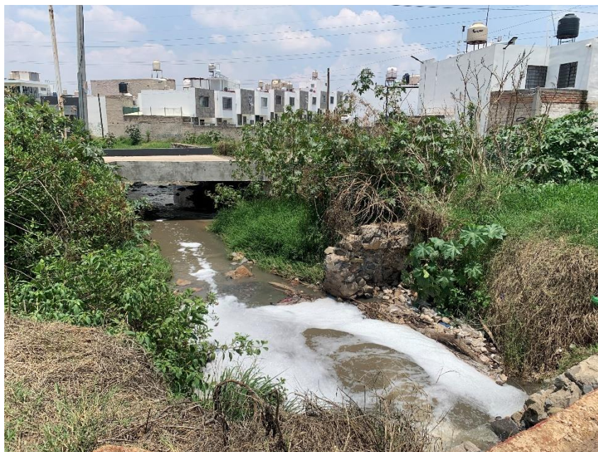
Figura. Estado actual del sitio del proyecto
