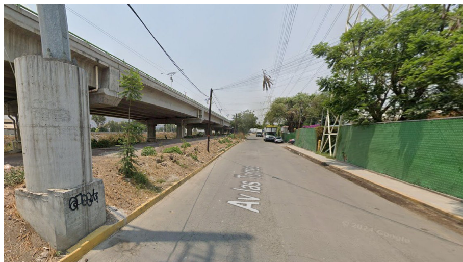
Principal vía de acceso a las instalaciones, avenida las Torres
