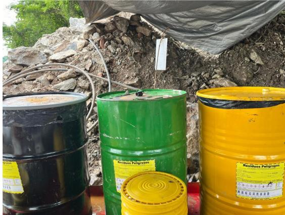
Fotografía 19. Almacenamiento temporal de insumos para perforación debidamente etiquetados. Se observa cómo se encuentran sobre material impermeable (nota: la imagen no corresponde a alguno de los puntos que se encuentran en evaluación)
