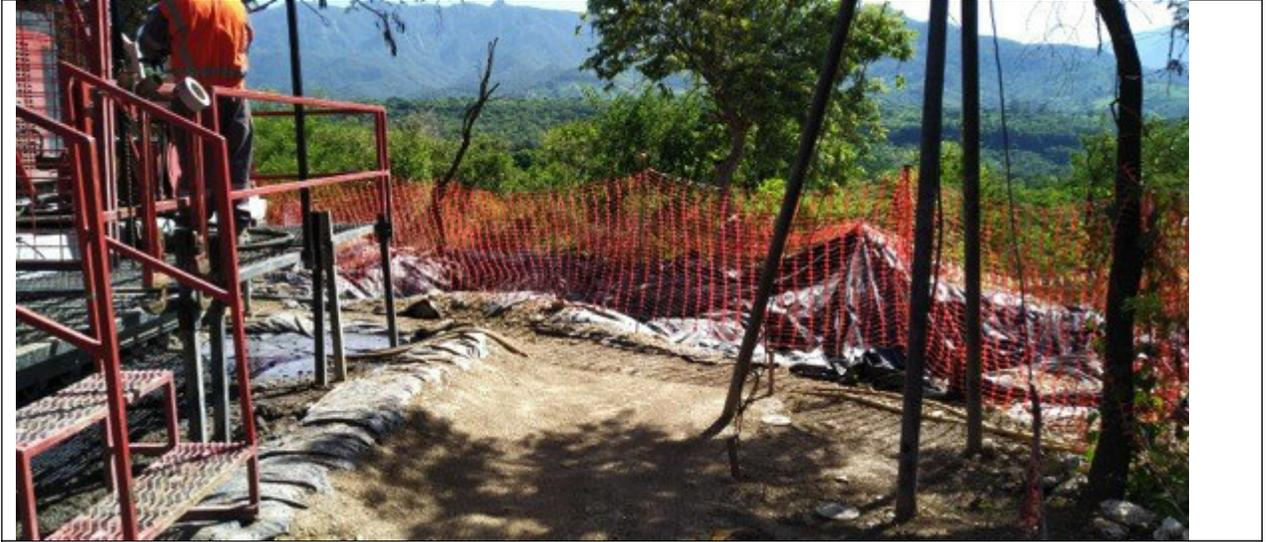
*Fotografía 7. Protección del suelo en máquina de perforación y cárcamos.*
