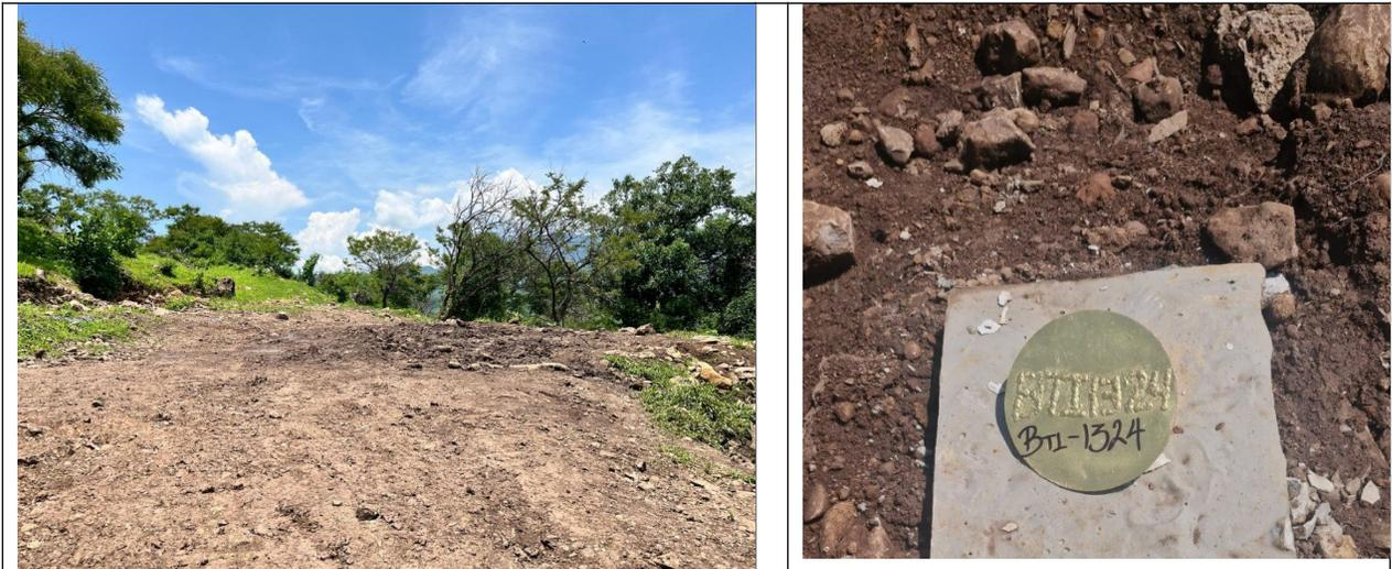
Fotografía 18. La limpieza del sitio y cementación de la boca del barreno.
