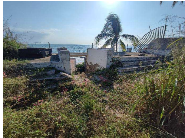
Imagen 14.- Vista hacia sur desde interior de sitio de proyecto, vegetación herbácea y obras existentes en la superficie de Zona Federal Marítimo Terrestre, obras existentes. mismas que no fueron construidas por el mismo
