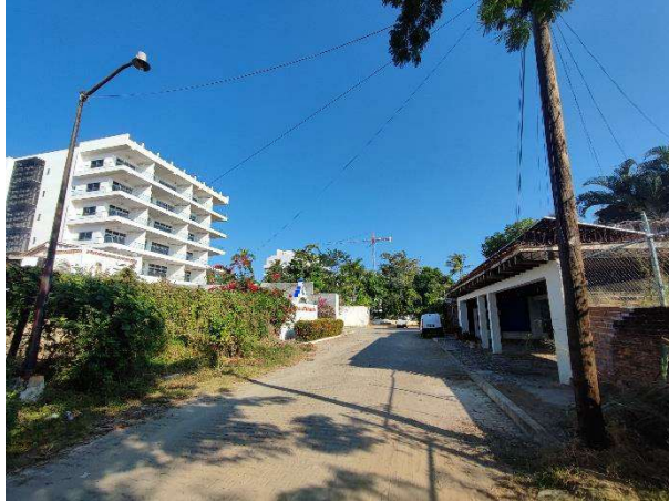
Imagen 1.- Vista hacia este, calle Pontoque, vialidad colindante a sitio de proyecto.
