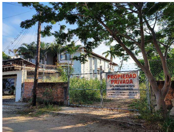
Imagen 24.- frente de proyecto en vialidad.
