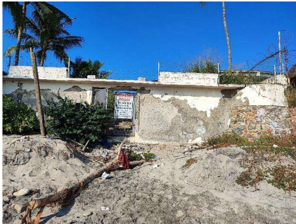
Imagen 17.- Vista hacia norte desde superficie de Zona Federal Marítimo Terrestre, obras existentes. mismas que no fueron construidas por el mismo.
