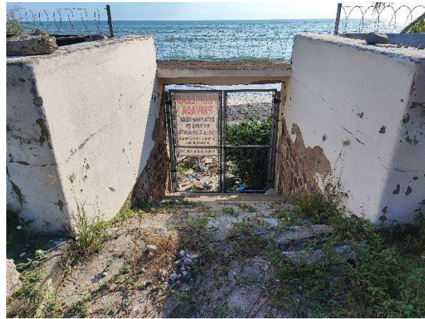
Imagen 16.- Vista hacia sur desde interior de superficie de Zona Federal Marítimo Terrestre, obras existentes. mismas que no fueron construidas por el mismo
