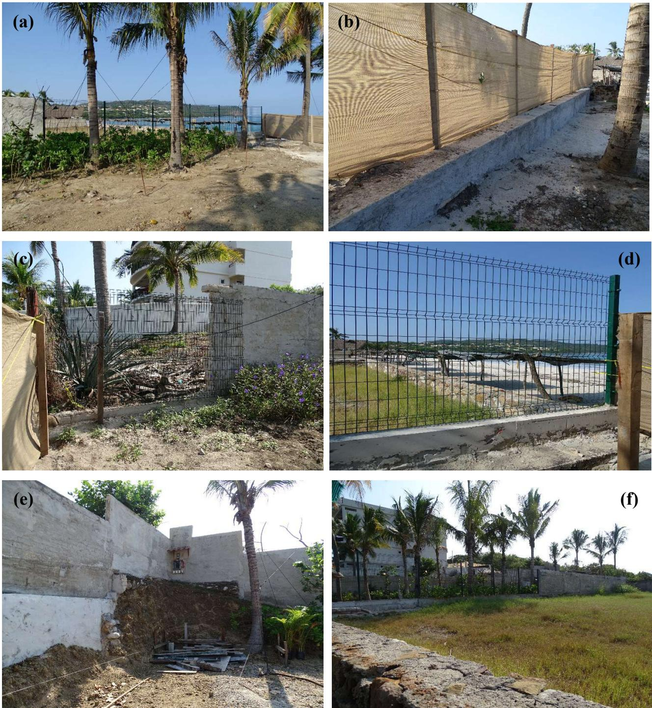
**Figura II-6.** En (a) se muestra el lado oeste de la barda lateral, en (b) el muro de contención colindante con el área de playa, en (c y d) la parte este y oeste de la barda perimetral constituida por paneles de reja, en (e) se muestra detalle de la altura de la barda frontal y barda lateral este y en (f) la barda lateral del lado oeste vista desde el solar colindante.
