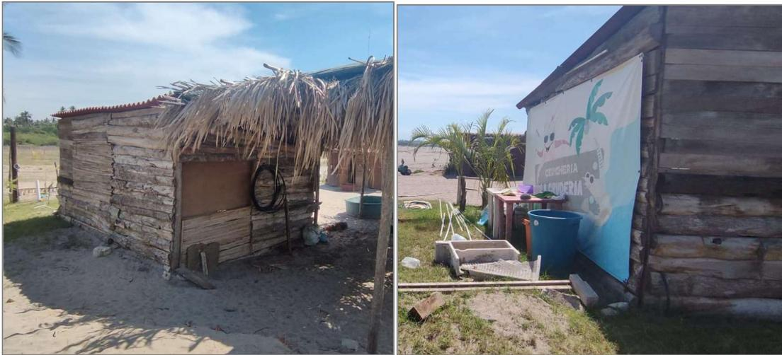
*asi como la instalacion de baños contruidos con material de la region madera con techo de lamina de asbesto y piso de cemento en una superfcie de 8 metros cuadrados.*
