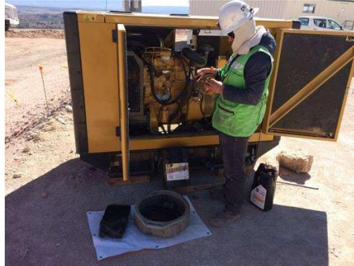
Figura II.16 Suministro de combustible con la aplicación de medidas de control de derrames.
