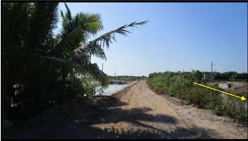
Fotografía 1. En la imagen se indica con la flecha en color amarillo, el canal de alimentación que utiliza la Instalación para su operación, al centro se tiene el bordo del reservorio de la instalación acuícola, este bordo permite el tránsito de vehículos para las operaciones y manejo de productos e insumos.
