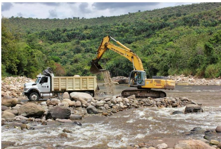
**Figura II.4.** Ejemplo de la forma de extracción de material pétreo en greña y carga directa de camiones volteos.
