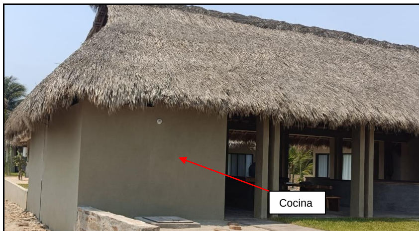
Fotografía 6. Área de cocina ubicada del lado oeste de la palapa.
