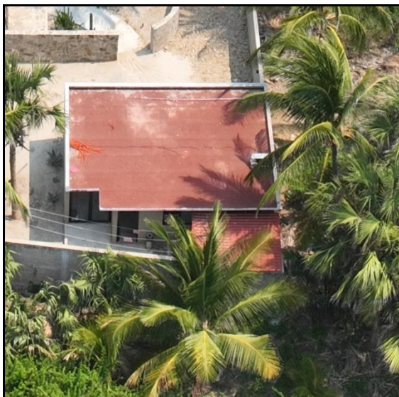
Fotografía 50. Ubicación del cuarto de blancos enfrente de la habitación de servicio.
