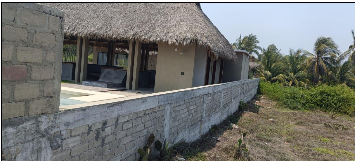
Fotografía 57. Colindancia este del sitio del proyecto donde colinda con un terreno baldío que se encuentra desprovisto de vegetación forestal, dado que anteriormente fueron empleados para cultivos agrícolas.
