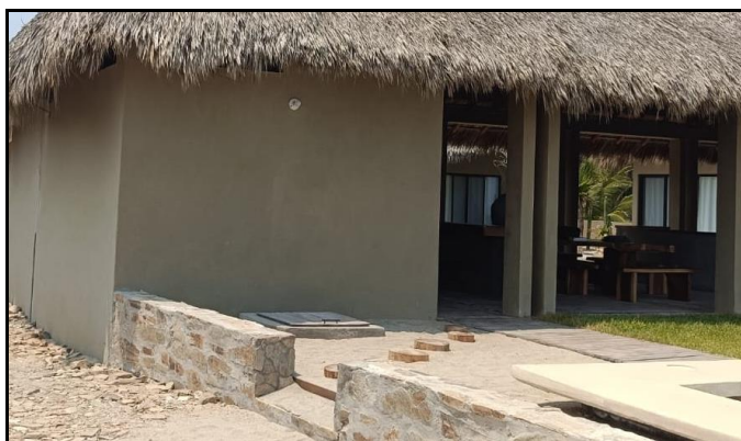
Fotografía 49. Vista lateral del muro de piedra 1 y 2.
