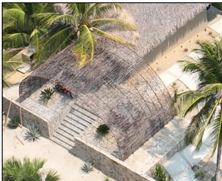
Fotografía 18. Construcción de una estructura en forma de arco que será ocupada como área de descanso.
