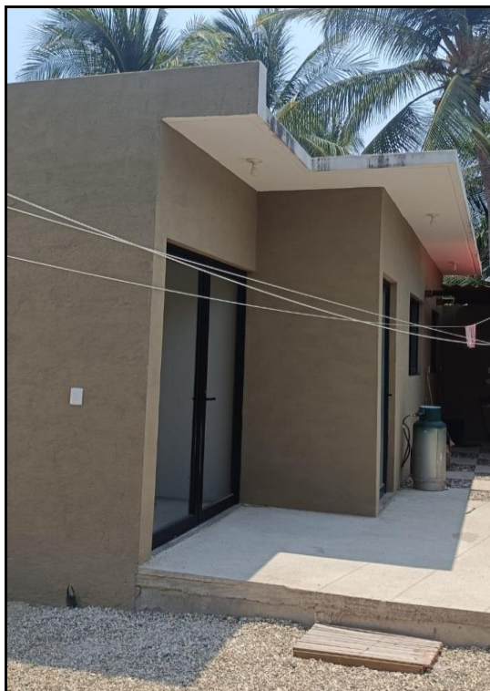
Fotografía 16. Habitación y bodega que se encuentran en el lado noreste del predio del proyecto.
