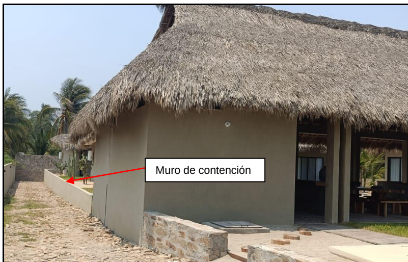
Fotografía 21. Muro de contención existente en el sitio del proyecto.
