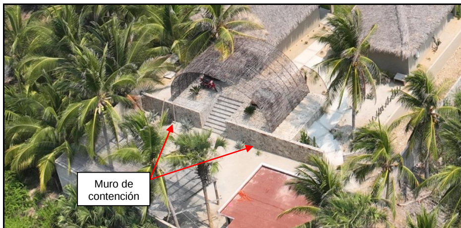
Fotografía 17. Muro de contención existente en la zona del proyecto.
