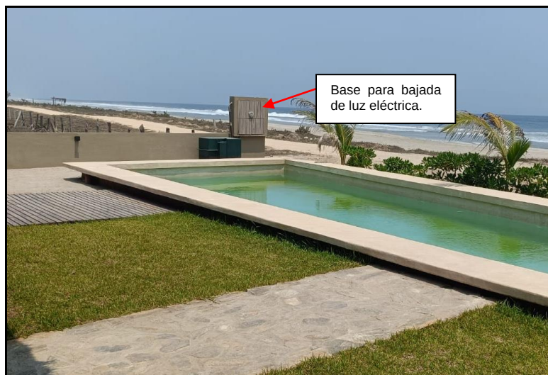
Fotografía 2. Base para bajada de luz eléctrica.
