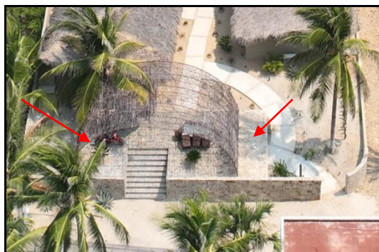
Fotografía 41. Pasillo de concreto y piedra que rodea el área de descanso.
