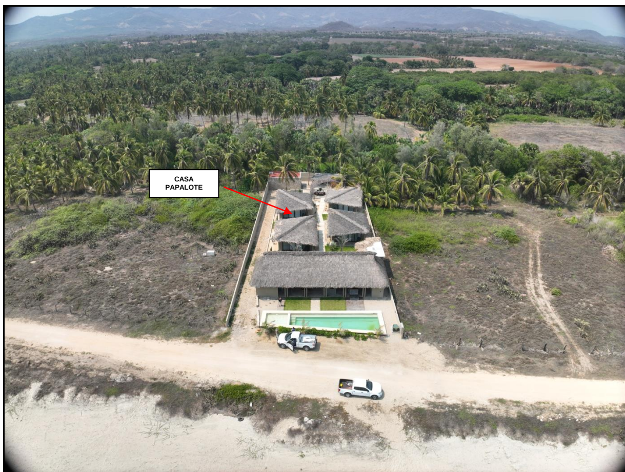
Fotografía 31. Nótese que las obras del proyecto ya están concluidas, quedando solo pendientes acabados, pintura e instalaciones en general.
