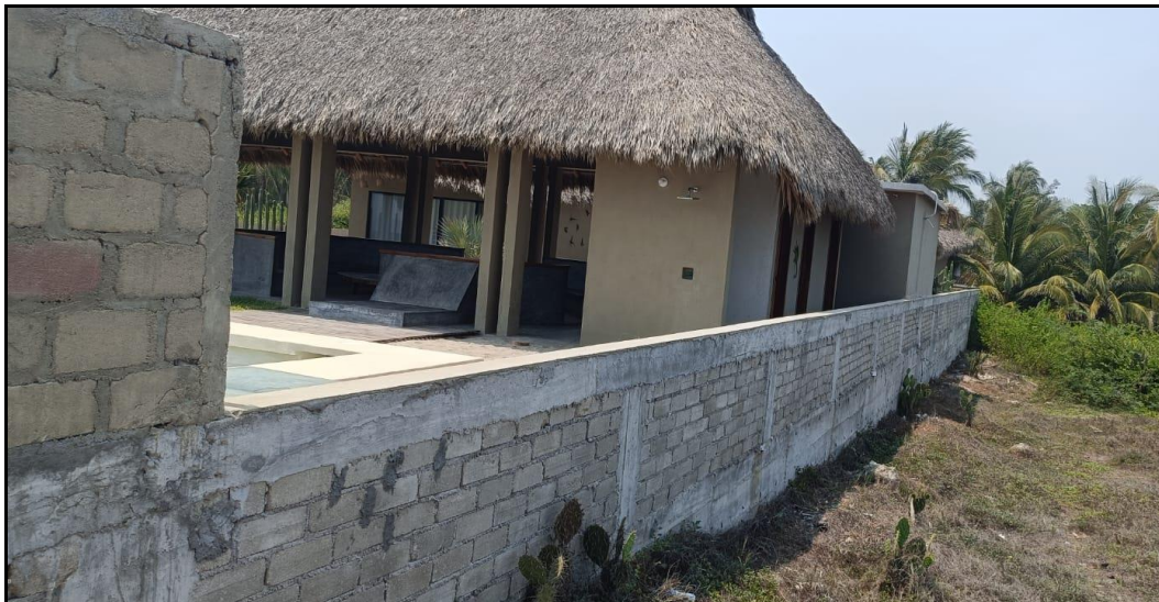
Fotografía 23. Barda perimetral del lado Este del predio destinado para el proyecto.
