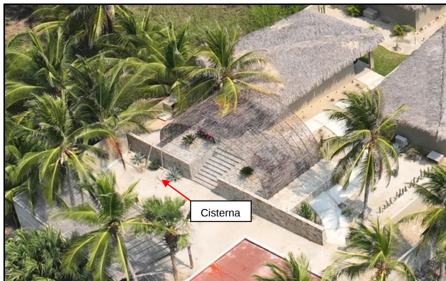
Fotografía 15. Localización de la cisterna de agua.
