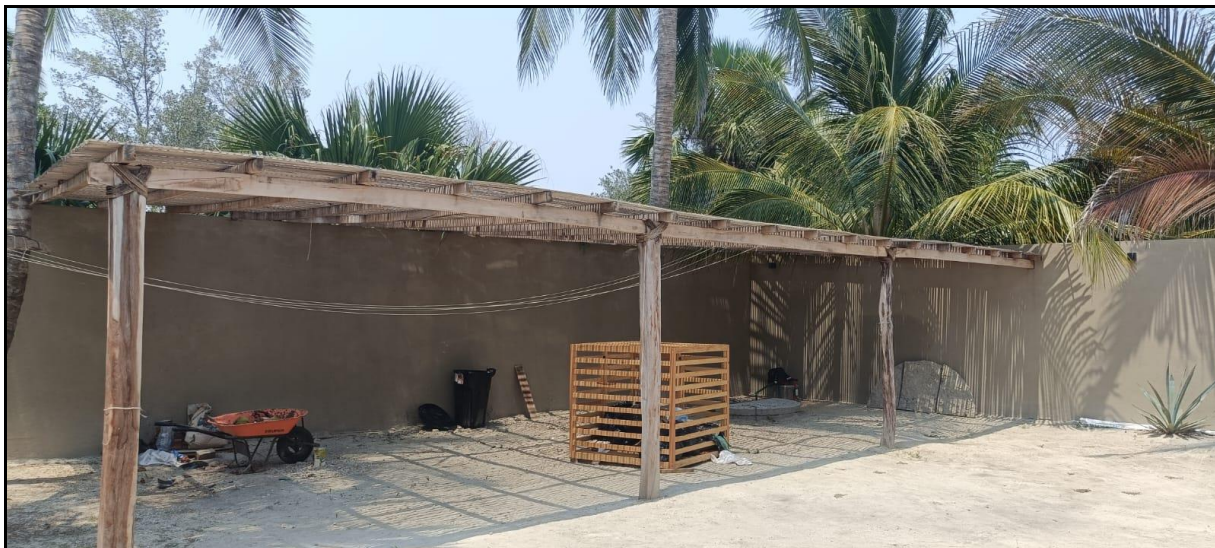
Fotografía 19. Área que será ocupada para el estacionamiento.
