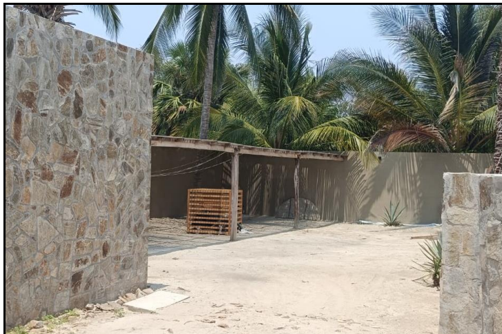
Fotografía 44. Pasillo de acceso que llega al área de estacionamiento.
