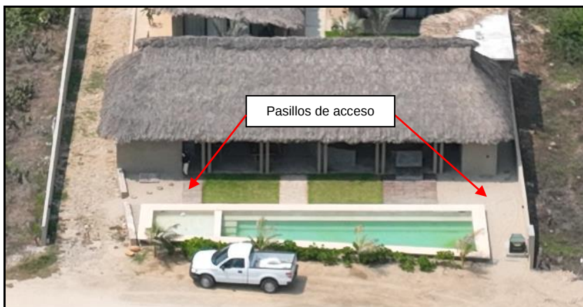
Fotografía 45. Pasillo de acceso del lado este y oeste del sitio del proyecto.
