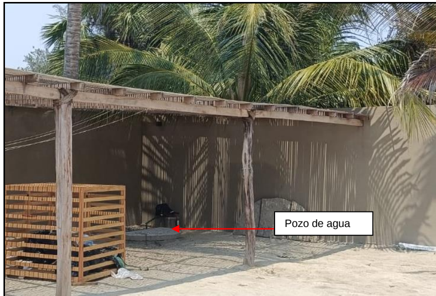
Fotografía 14. Pozo de agua presente en el sitio del proyecto.
