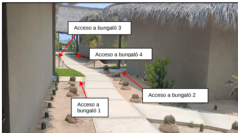
Fotografía 47. Ubicación de los pasillos de acceso a los bungalós.
