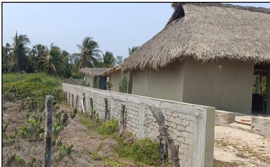
Fotografía 25. Barda perimetral del lado Oeste del predio destinado para el proyecto.
