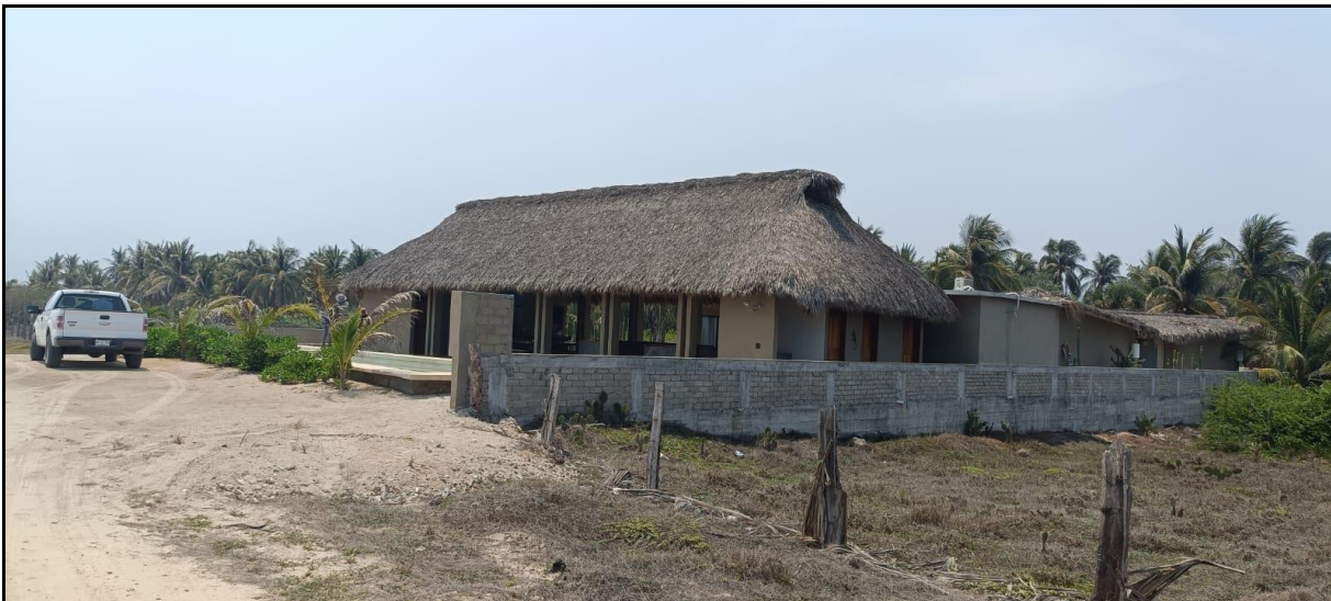
Fotografía 55. En la colindancia Suroeste, nótese la existencia de un camino cosechero que sirve de acceso a la zona del proyecto.
