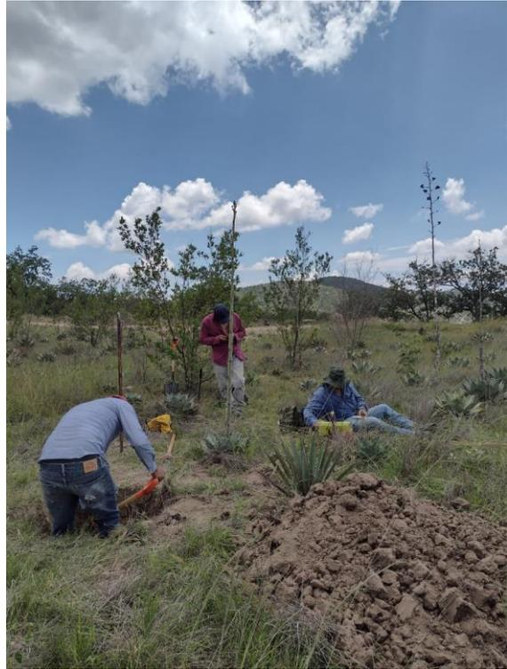
Figura IV. 30 Excavación de pozo 1 a cielo abierto muestra obtenida a 1.8 metros
