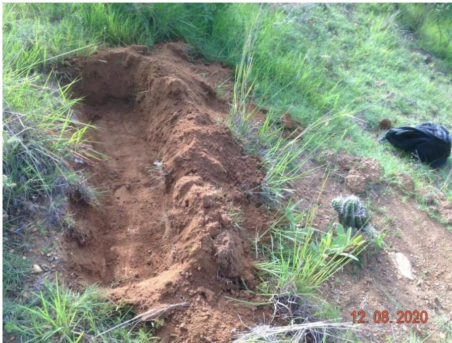
Figura VI. 13: Diseño en campo de las Zanjas Trincheras.
