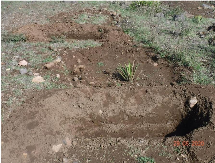
Figura VI. 12: Diseño en campo de las Zanjas Trincheras.
