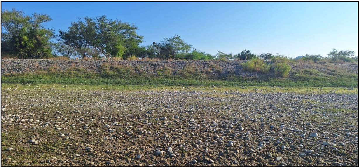
Fotografía 5. Nótese el hombro del cauce del río en la margen izquierda que las autoridades locales han construido con la intención de proteger los terrenos aledaños por posibles desbordamientos en la temporada de lluvias.
