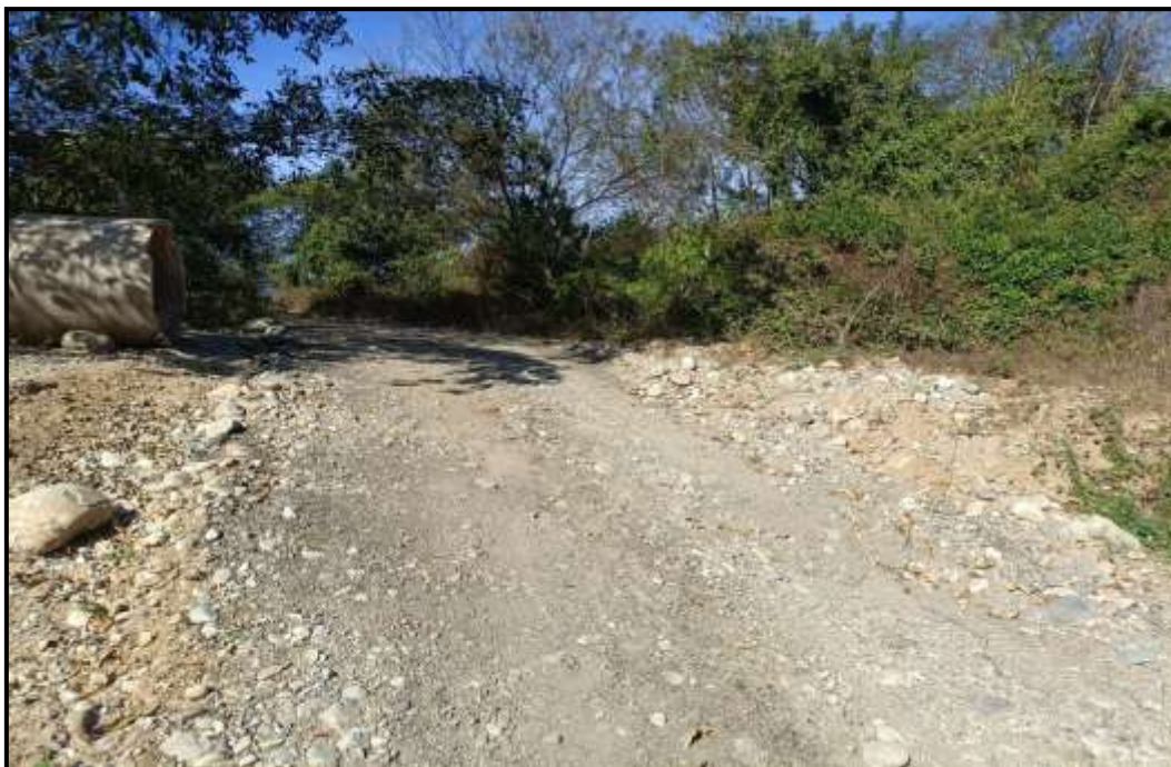
Fotografía 10. Condiciones actuales del camino de acceso a la zona de aprovechamiento del material pétreo.
