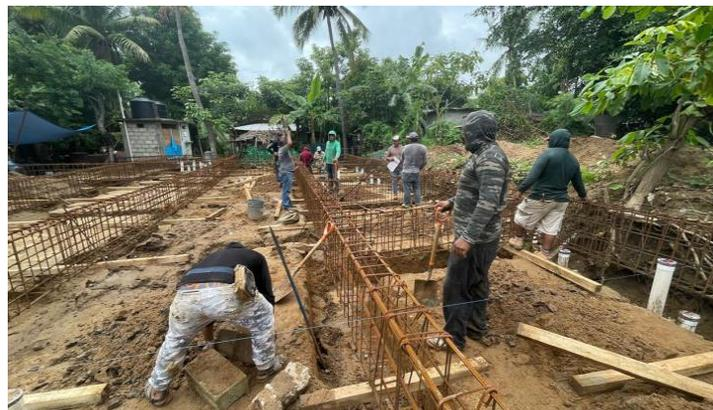
**Figura II.91.** Armado de castillos muros y traveses.
