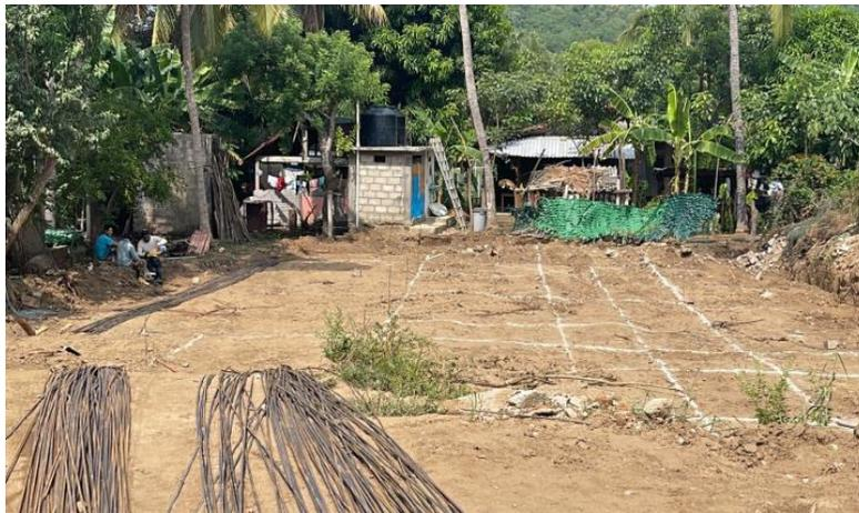
**Figura II.89.** Trazo del diseño arquitectónico del Hotel Santa Cruz Mazunte.
