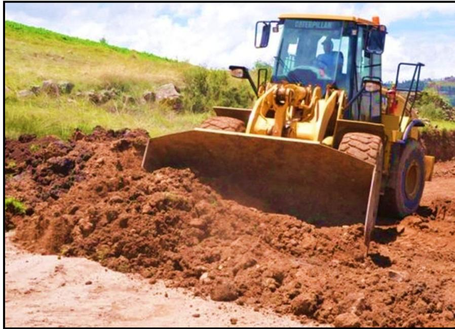
Ilustración II-21. Ejemplo del despalme del terreno, remoción de capa orgánica vegetal.
