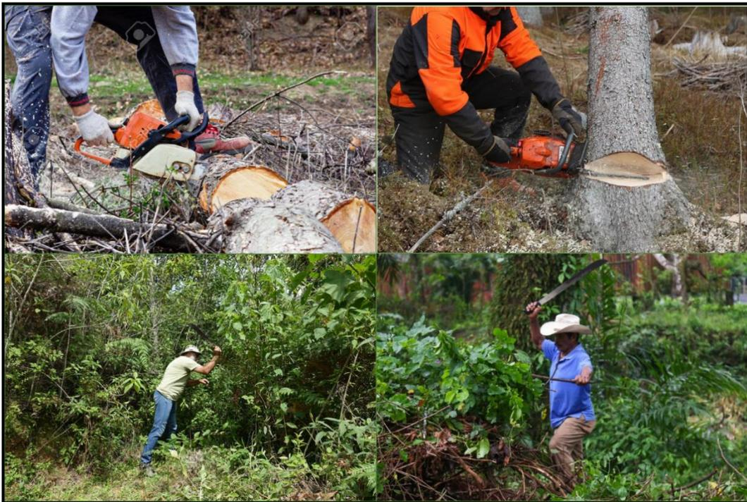
Ilustración II-20. Ejemplo del desmonte con Motosierra y Machete
