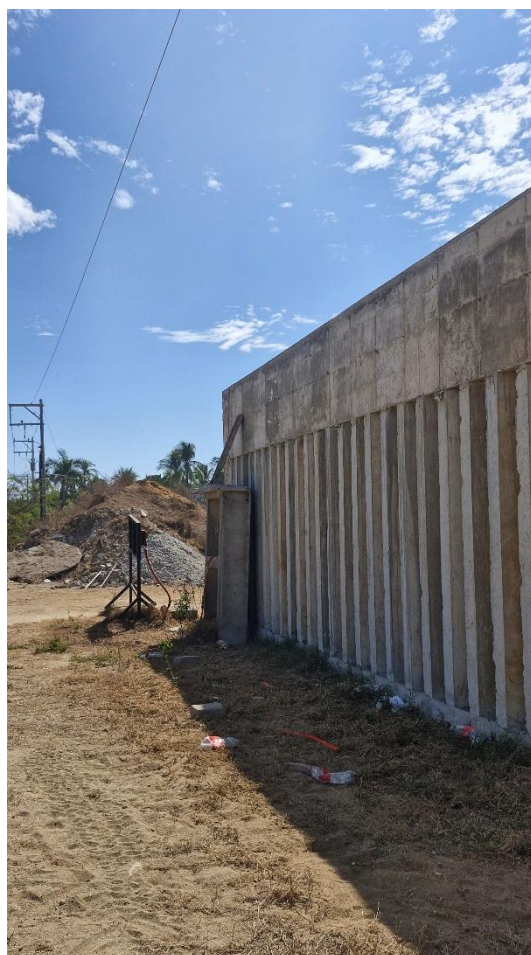
Imagen 38. Bloque que conforma la fachada del proyecto, zona este.
