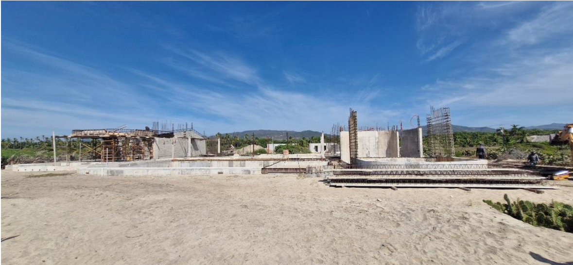
Imagen 35. Fachada sur del proyecto, este punto es el más cercano con la ZOFEMAT.
