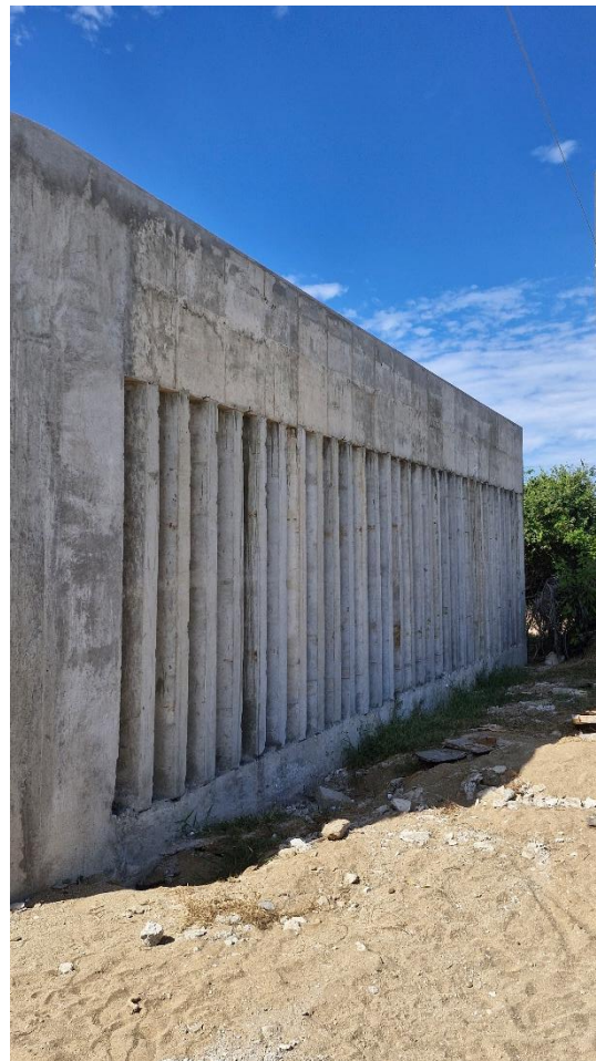
Imagen 36. Bloque que conforma la fachada del proyecto, zona oeste.
