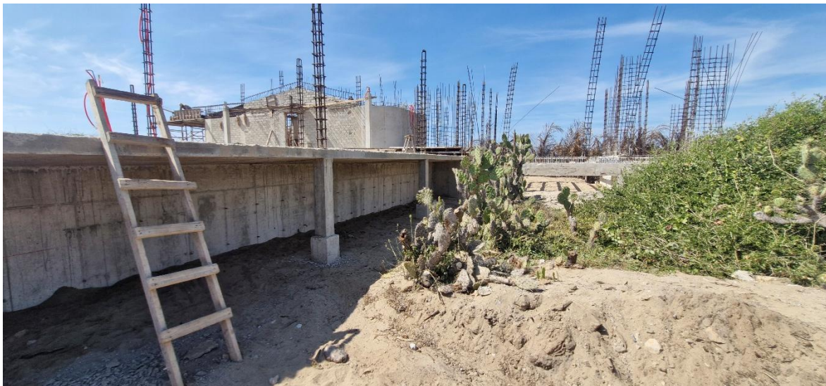
Imagen 43. Zona interior del proyecto, en dirección oeste del predio.
