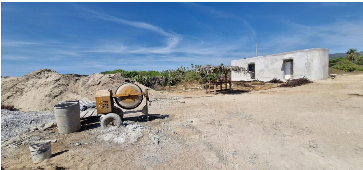
Imagen 39. Zona central dentro del polígono del proyecto en dirección noroeste.
