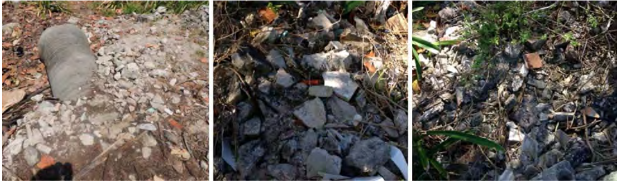
Condiciones del suelo al interior del predio.
