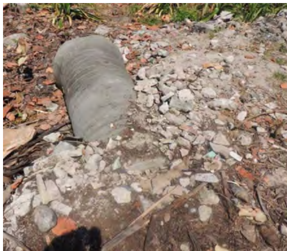
Tubería abandonada en el interior del predio, zonas con rellenos con cascajo antiguo y materiales derivados de obras no asociadas al presente proyecto, cimentaciones antiguas, marcan y determinan el ensamble general del sitio.
