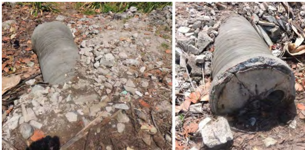
Pedazo de tubo de cemento abandonado en el interior del predio.
