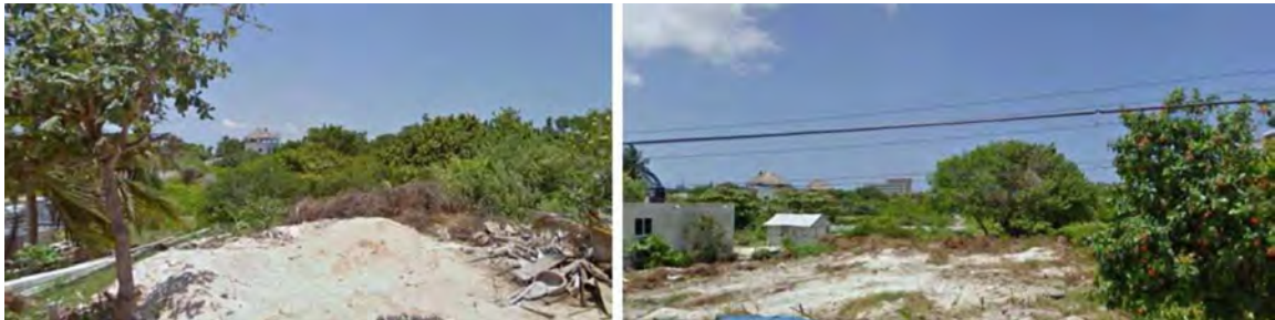
Se advierten varios espacios con el suelo desnudo u ocupado por restos de materiales derivados de la construcción.
