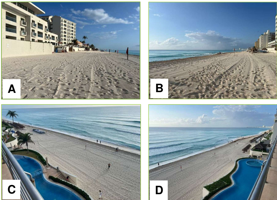
Ilustración 24. Área de playa del Hotel Emporio. A. Norte a nivel del suelo; B. Sur a nivel del suelo; C. Norte vista superior; D. Sur vista superior.
