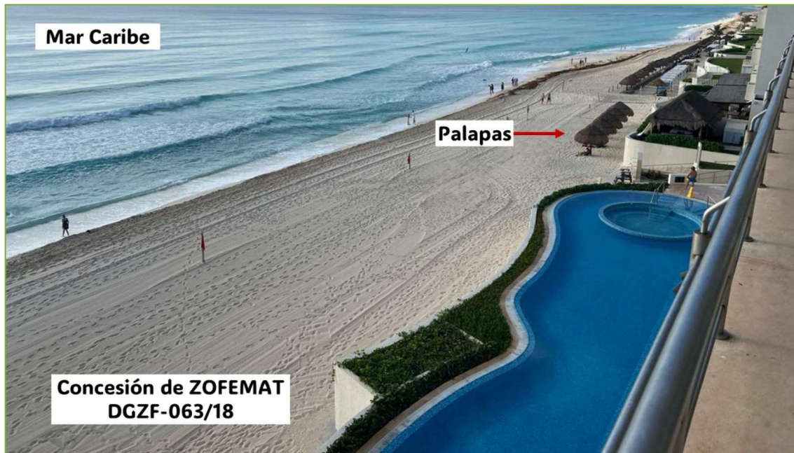
Ilustración 8. Vista general del área actual, colindancias visibles del proyecto: vista a la derecha (Sur) 5 palapas tipo sombrilla.
