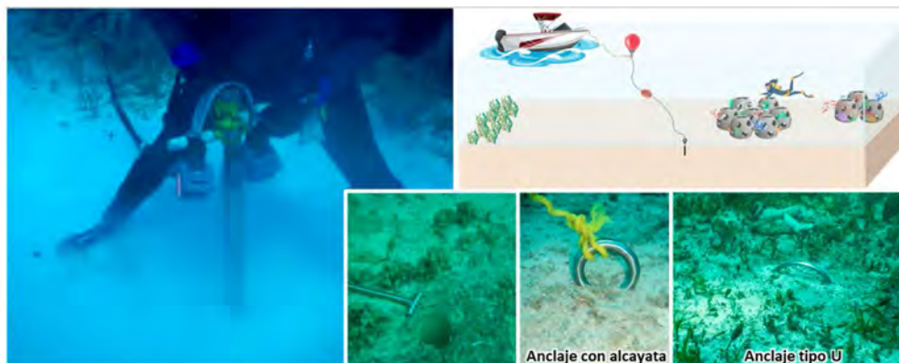
Figura II_19.- Colocación del sistema de boyeo. Imágenes ilustrativas tomadas de otros proyectos e internet 4 .
