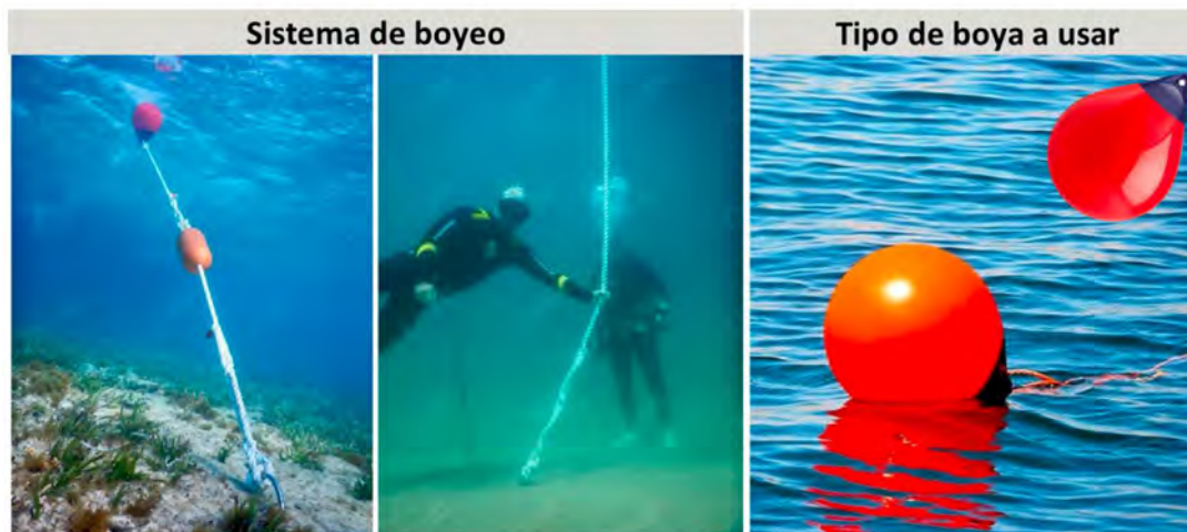
Figura II_20.- Colocación del sistema de boyeo. Imágenes ilustrativas tomadas de otros proyectos e internet 4 .
