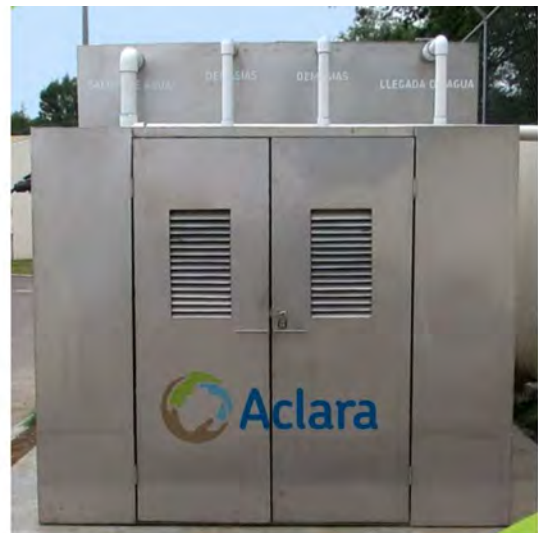
Figura 7. Imagen ilustrativa de una PTAR compacta de paquete.
