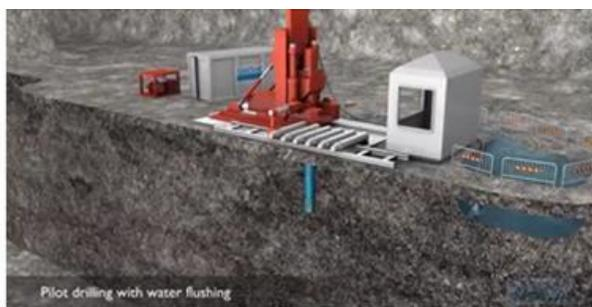
**Inicio de la perforación del barreno piloto**
