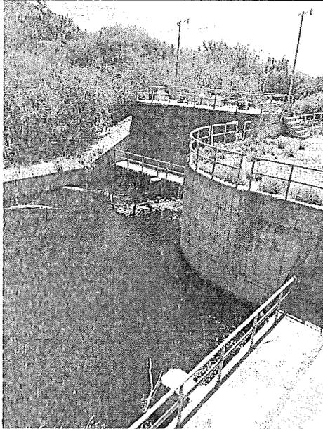
Foto 1. Obras de infraestructura de las compuertas del canal donde se pretende construir la obra de captación para su posterior bombeo al acueducto también en proyecto.
