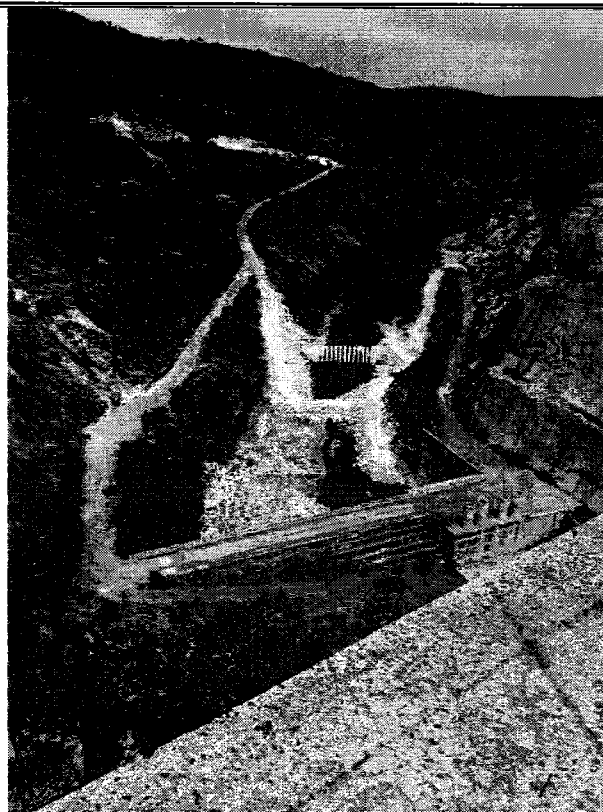
Vista desde la corona de la presa, aguas arriba de la misma, poco caudal también.
