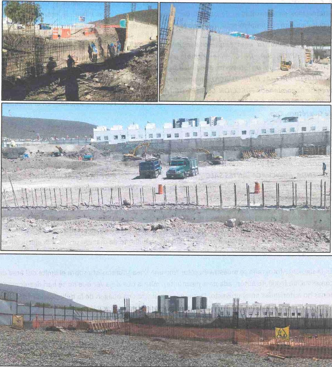
Figura 38 Construcción de muros de contención
