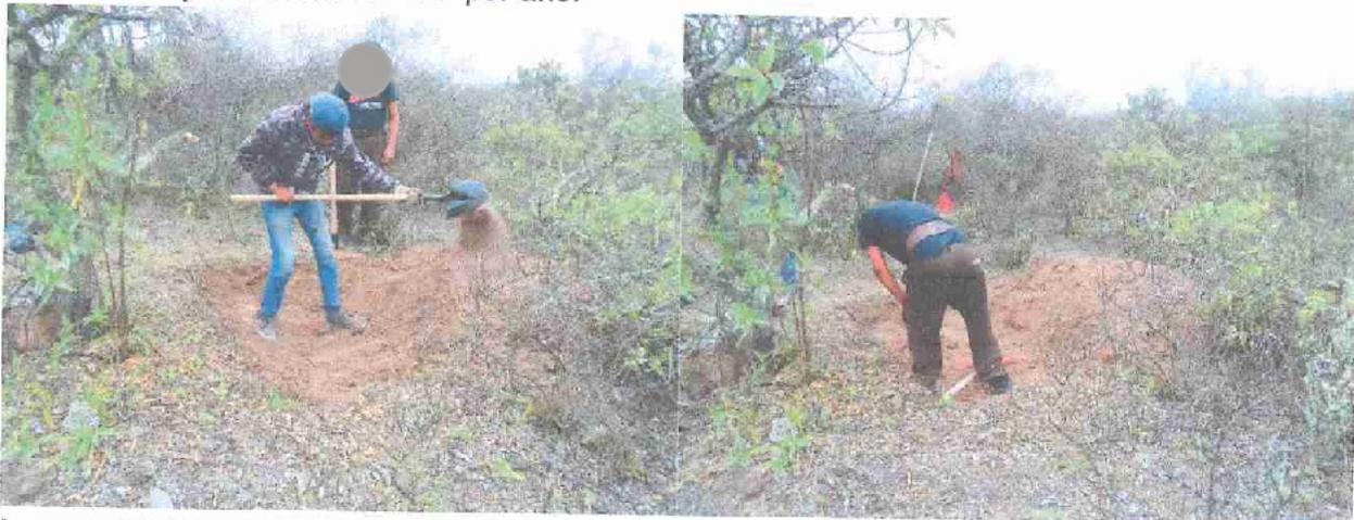
Imagen 97. Proceso constructivo de una tinaja ciega o zanja trinchera.
