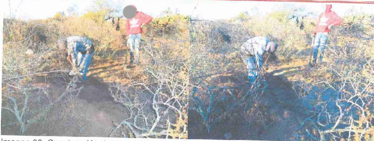
Imagen 98. Construcción de tinas ciegas o zanjas trincheras de 0.50 x 0.50 x 3.00 m de largo.
