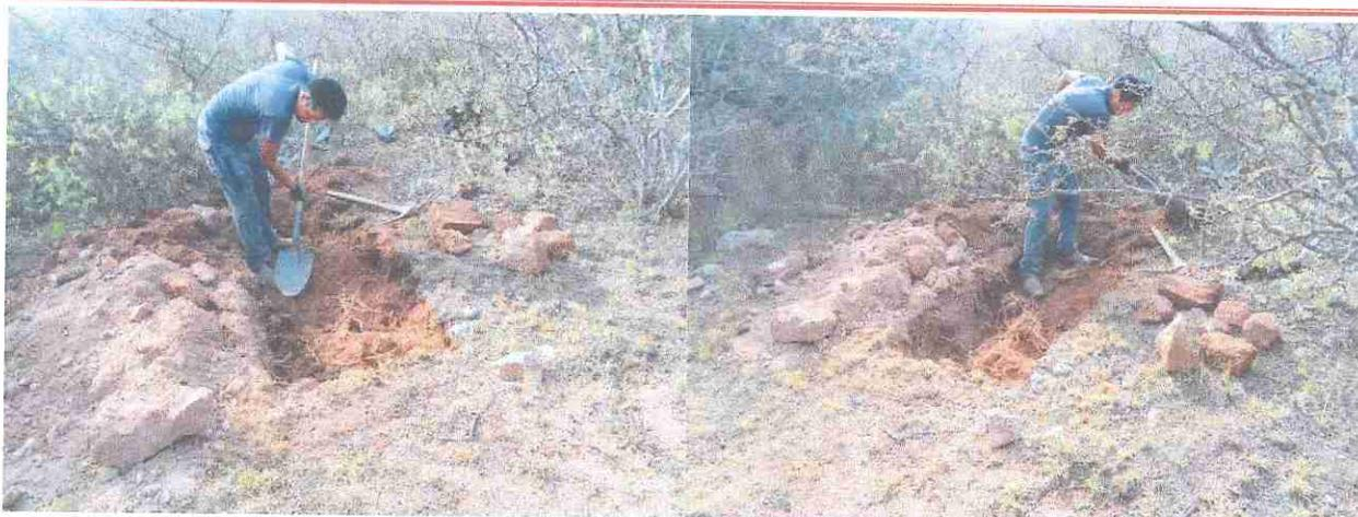
Imagen 92. Proceso constructivo de una tina ciega o zanja trinchera para captacion de agua de lluvia del proyecto Banco de materiales petreos.
