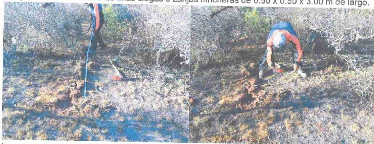
Imagen 99. Delimitación de tina ciega o zanja trinchera de 0.50 x 0.50 x 3.00 metros de largo.
