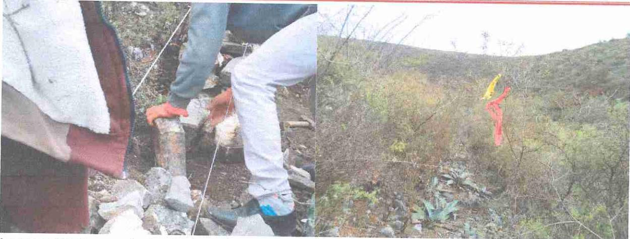
Imagen 70. Acomodo de piedra sobre el trazo que sigue la curva de nivel donde se construye la barrera de piedra acomodada en el área uno y dos de la superficie a CUSTF.
