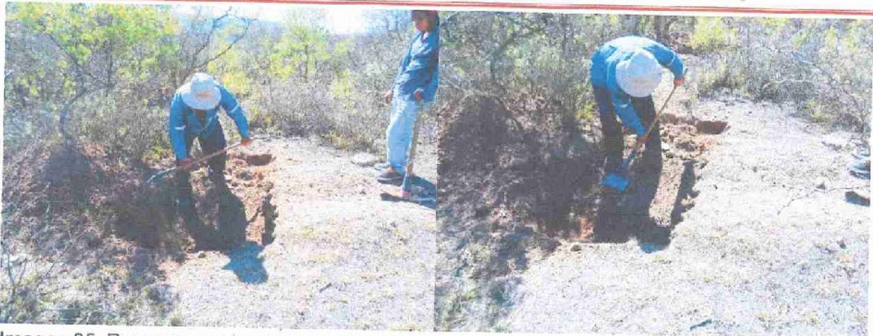
Imagen 95. Proceso constructivo de tinajas ciegas o zanja trinchera con capacidad de  $0.75 \text{ m}^3$  por año.
