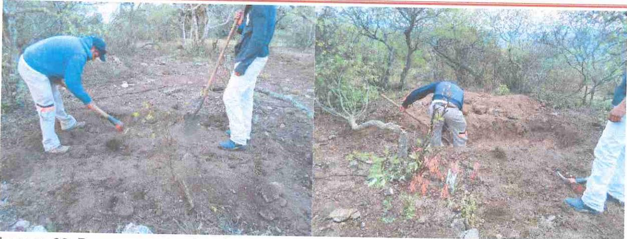
Imagen 89. Proceso constructivo de tinajas ciegas o zanjas trincheras para captación de agua de lluvia.
