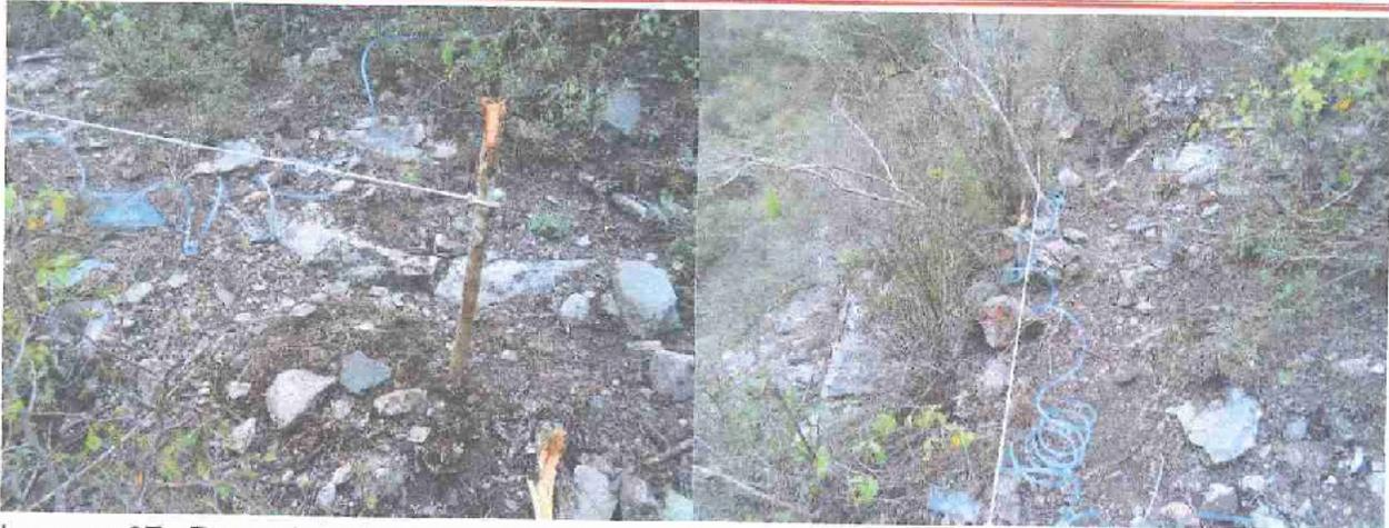
Imagen 67. Paso del nivel con manguera sobre la cota de los 1980 msnm donde fueron construidos los 2727 metros lineales de barrera de piedra acomodada.
