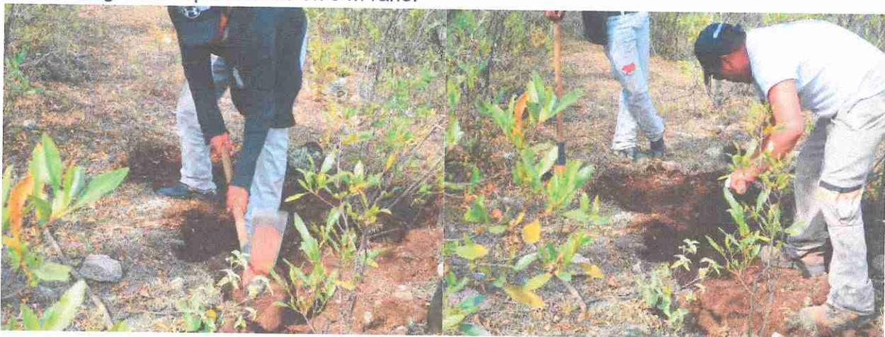
Imagen 91. Excavación de tina ciega o zanja trincheras con capacidad de 0.75 m<sup>3</sup> por año.
