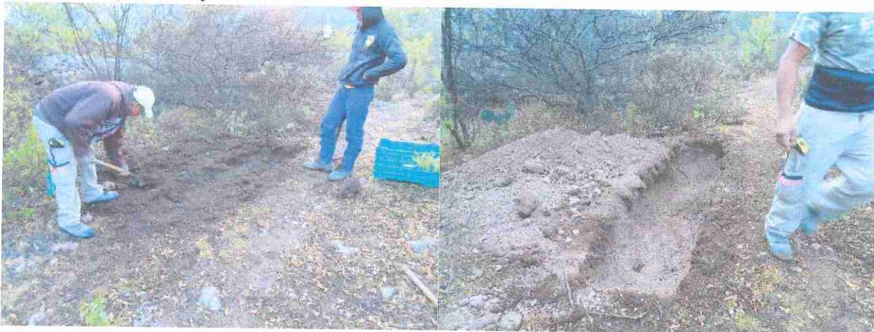
Imagen 88. Construcción de tina ciega o zanja trinchera en curva de nivel para captación de agua de lluvia.
