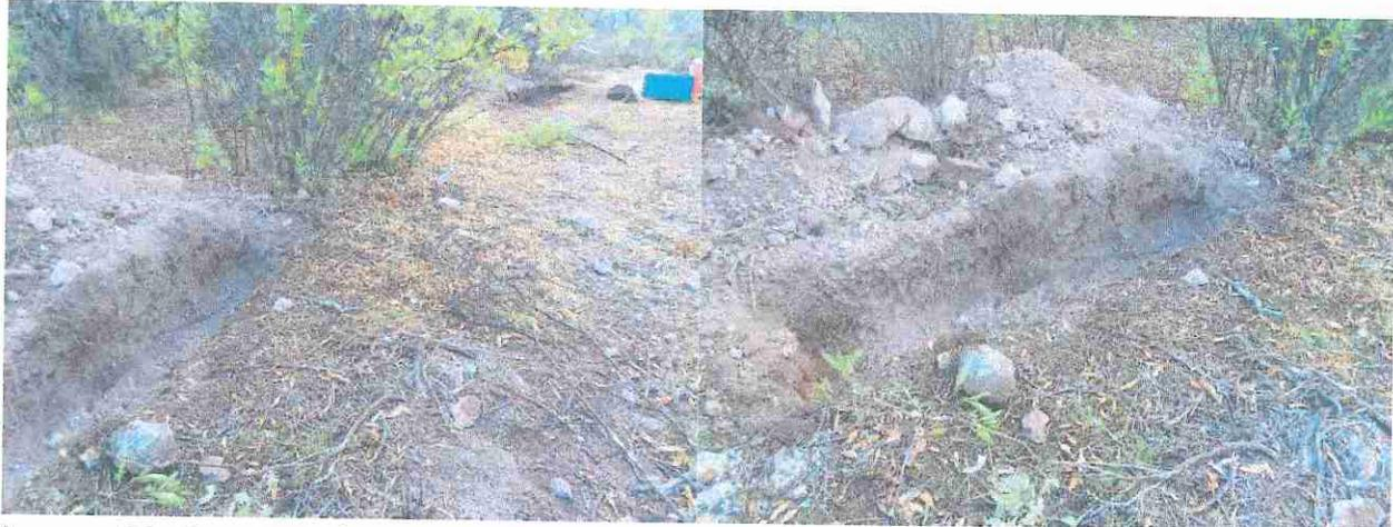
Imagen 90. Construcción de tinajas ciegas o zanjas trincheras en curva de nivel de 0.50 x 0.50 x 3.00 de largo con capacidad de 0.75 m<sup>3</sup>/año.
