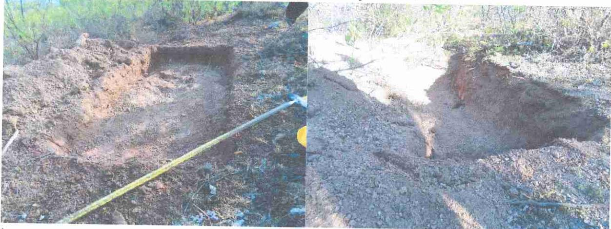
Imagen 102. Tinan ciegas o zanjas trincheras terminadas y detalladas con las dimensiones propuestas.
