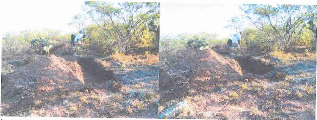
Imagen 96. Distanciamiento de 3.00 entre zanja y zanja de dimensiones  $0.50 \times 0.50 \times 3.00$  de largo con capacidad de  $0.75 \text{ m}^3$  por año.
