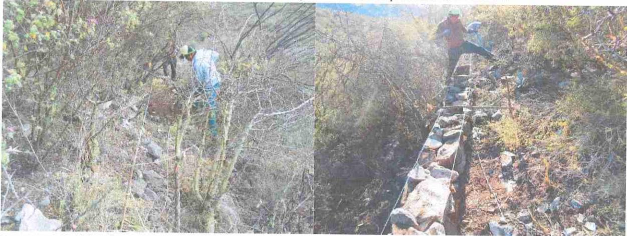
Imagen 71. Limpieza y nivelación de la base para el acomodo de piedra en la construcción de la barrera de piedra acomodada.
