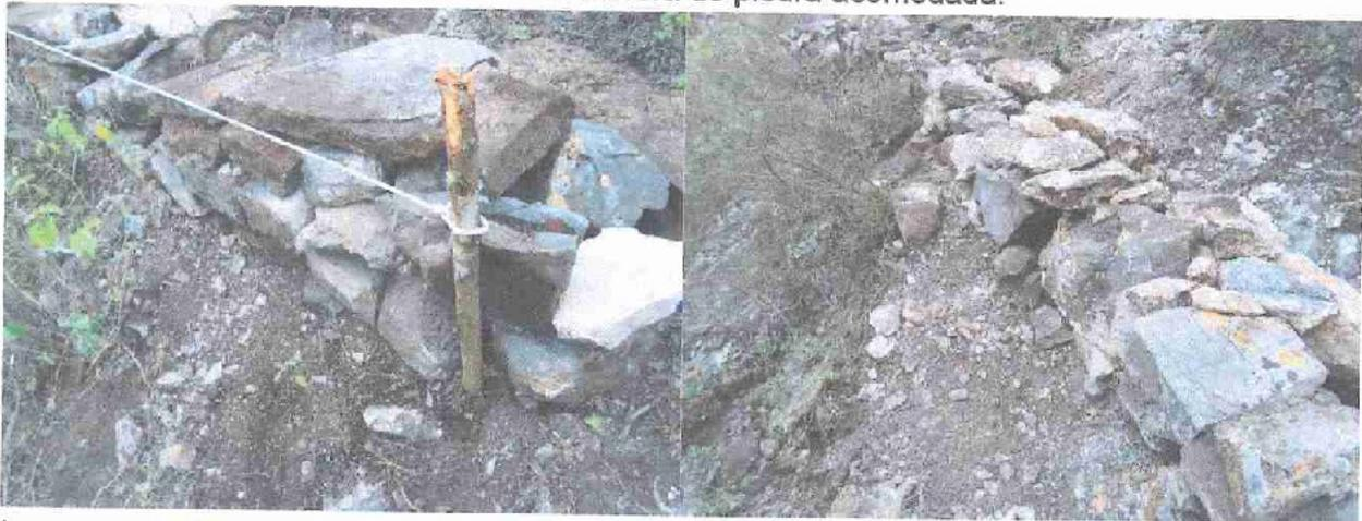
Imagen 68. Construcción de barrera de piedra acomodada de 0.30x030m la cual tiene la capacidad de retener 0.54 ton/ha/año de sedimentos en las áreas de las etapa uno y dos.
