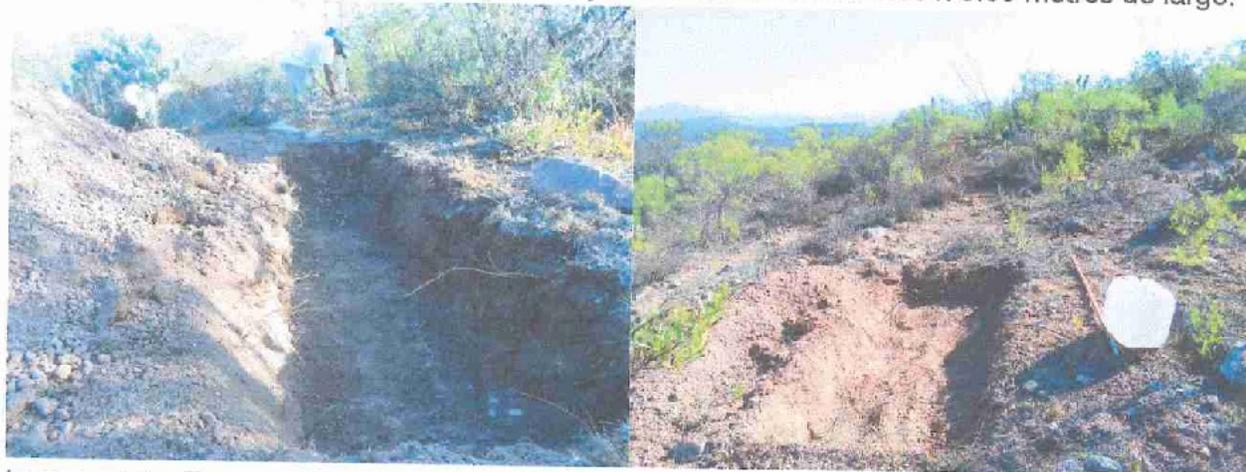
Imagen 100. Tinas ciegas o zanjas trincheras detalladas con sus dimensiones propuestas de 0.50 x 0.50 x 3.00 de largo.
