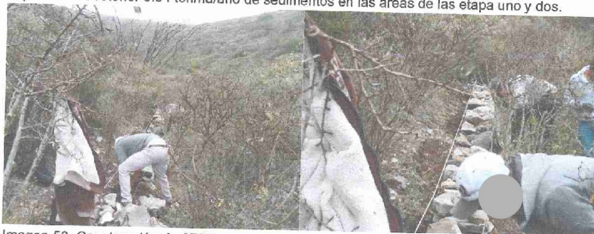
Imagen 58. Construcción de 2727 metros lineales de barrera de piedra acomodada en curva de nivel en la superficie de las etapas uno y dos del área autorizada para cambio de uso de suelo en terrenos forestales.
