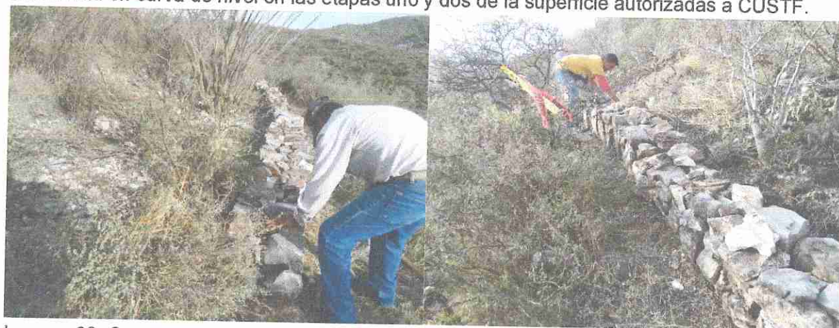
Imagen 62. Construcción de barrera de piedra acomodada en curva de nivel en las áreas de las etapas uno y dos de la superficie autorizada para cambio de uso de suelo en terrenos forestales.
