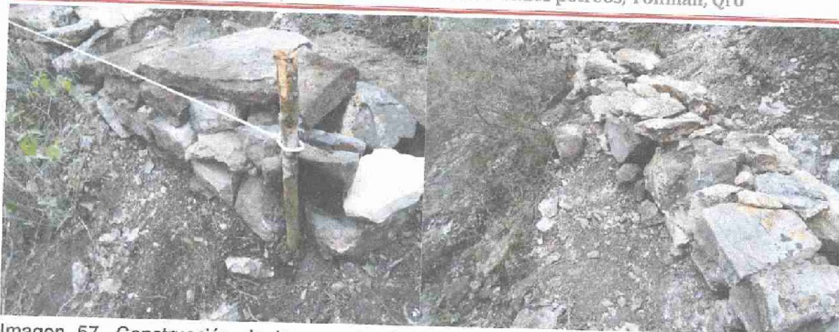
Imagen 57. Construcción de barrera de piedra acomodada de 0.30x030m la cual tiene la capacidad de retener 0.54 ton/ha/año de sedimentos en las áreas de las etapas uno y dos.
