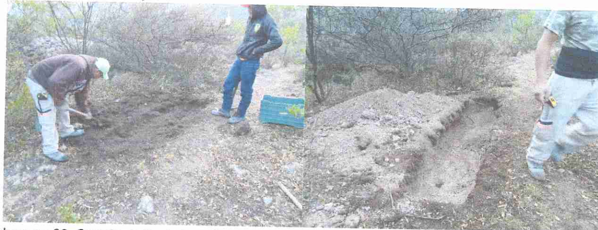
Imagen 83. Construcción de tina ciega o zanja trinchera en curva de nivel para captación de agua de lluvia.
