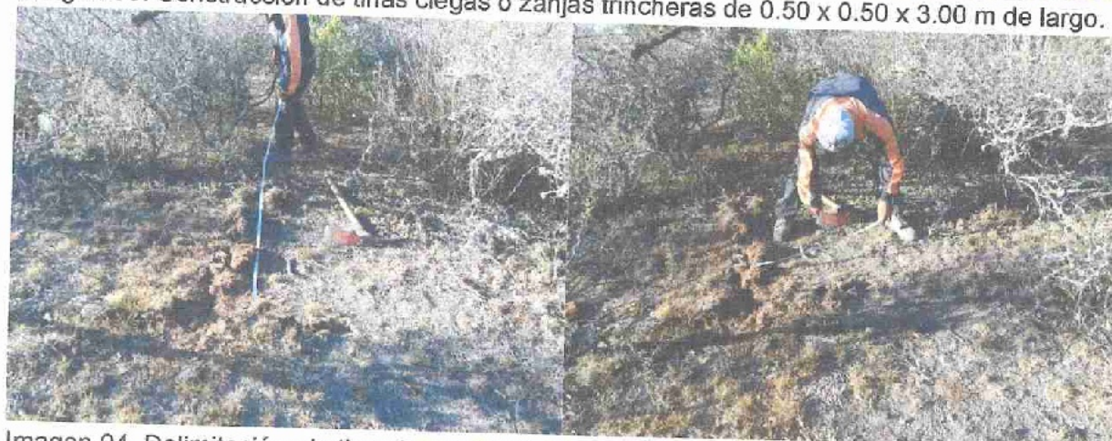
Imagen 94. Delimitación de tina ciega o zanja trinchera de 0.50 x 0.50 x 3.00 metros de largo.
