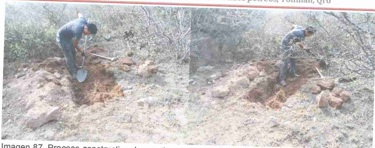
Imagen 87. Proceso constructivo de una tina ciega o zanja trinchera para captacion de agua de lluvia del proyecto Banco de materiales petreos.
