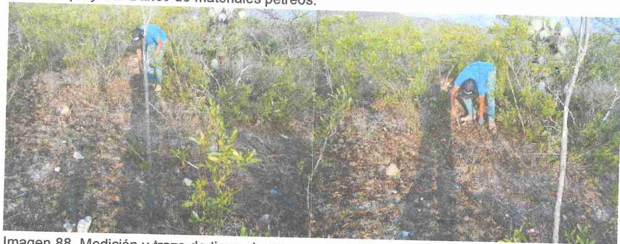
Imagen 88. Medición y trazo de tinas ciegas o zanjas tricheras de 0.50 x 0.50 x 3.00 m de largo con capacidad de 0.75 m 3 por año.
