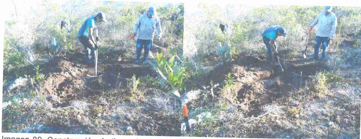
Imagen 89. Construcción de tinas ciegas o zanjas trincheras del proyecto Banco de materiales petreos.
