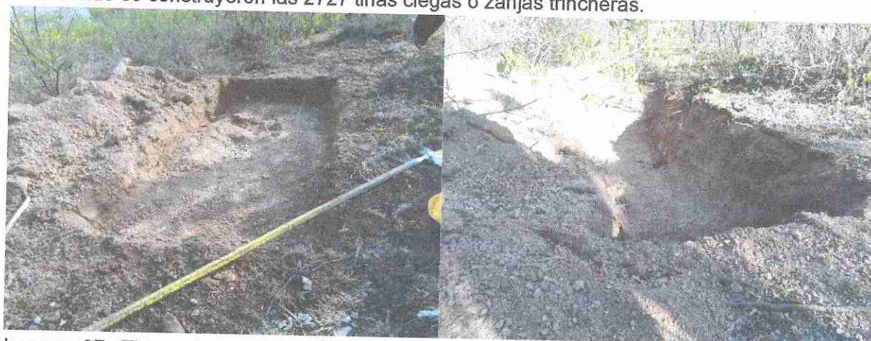
Imagen 97. Tinajas ciegas o zanjas trincheras terminadas y detalladas con las dimensiones propuestas.
