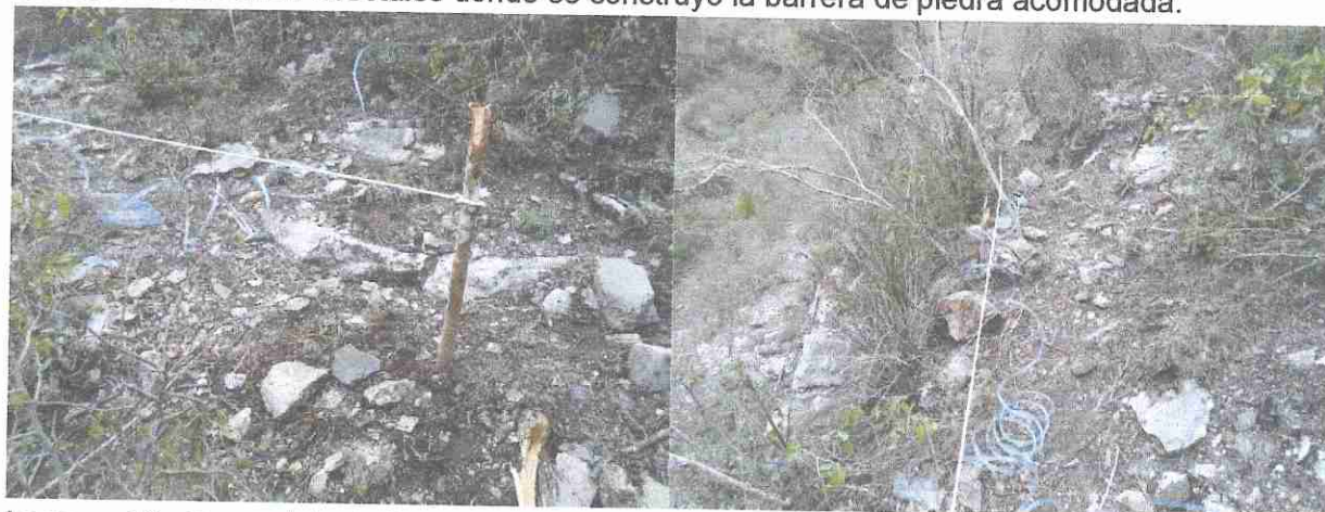
Imagen 56. Paso del nivel con manguera sobre la cota de los 1980 msnm donde fueron construidos los 2727 metros lineales de barrera de piedra acomodada.
