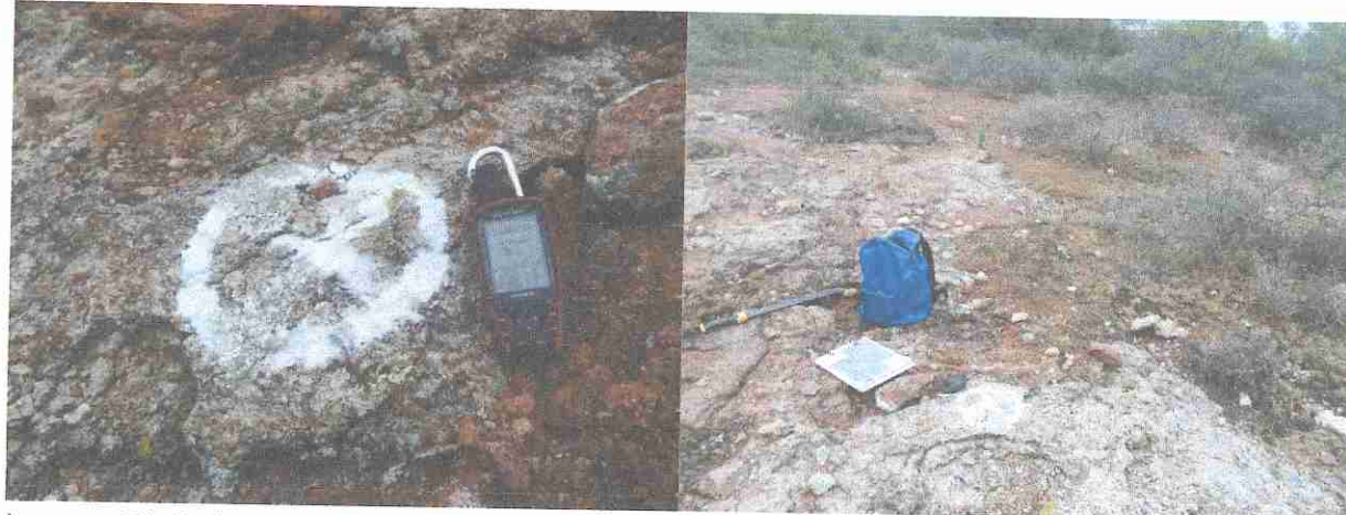
Imagen 80. Colocación y señalización de puntos de apoyo en curvas de nivel donde se ubicaron las tinajas ciegas o zanjas trincheras.
