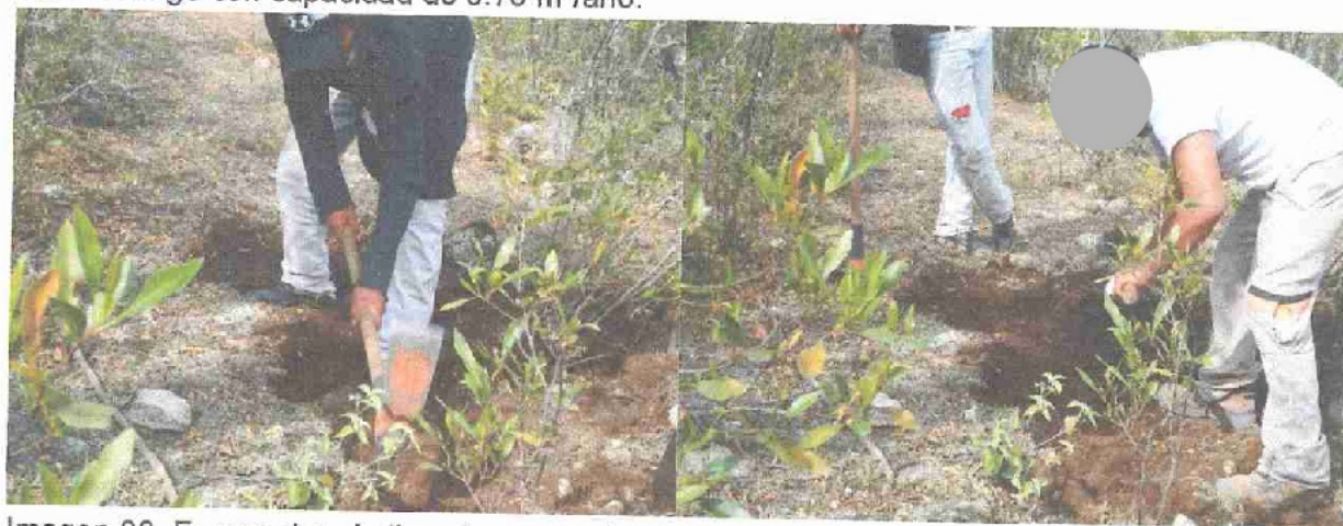
Imagen 86. Excavación de tina ciega o zanja trinchera con capacidad de 0.75 m 3 por año.
