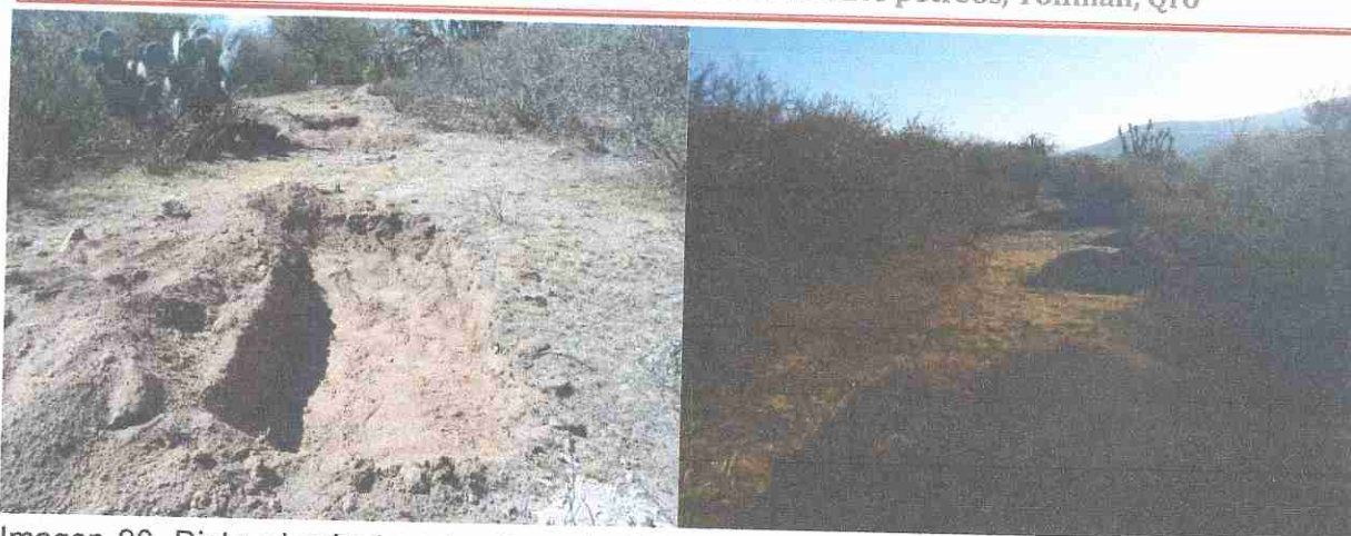
Imagen 96. Distanciamiento entre tinas de 3.00 metros sobre una misma curva de nivel en el area donde se construyeron las 2727 tinas ciegas o zanjas trincheras.
