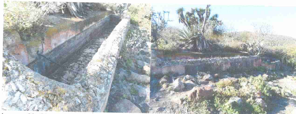
Imagen 98. Obras de captación de agua de lluvia antiguas ubicadas en las inmediaciones del area donde se construyeron las tinajas ciegas o zanjas trincheras, a decir de los pobladores dicen que hubo asentamientos humanos hace cientos de años.
