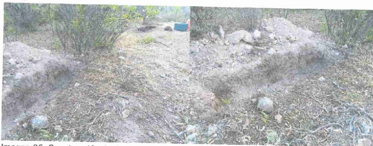
Imagen 85. Construcción de tinajas ciegas o zanjas trincheras en curva de nivel de 0.50 x 0.50 x 3.00 de largo con capacidad de 0.75 m 3 /año.
