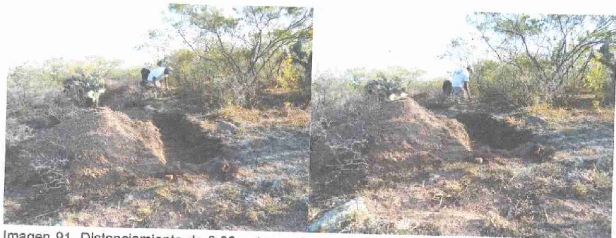
Imagen 91. Distanciamiento de 3.00 entre zanja y zanja de dimensiones 0.50 \times 0.50 \times 3.00 de largo con capacidad de 0.75 \text{ m}^3 por año.
