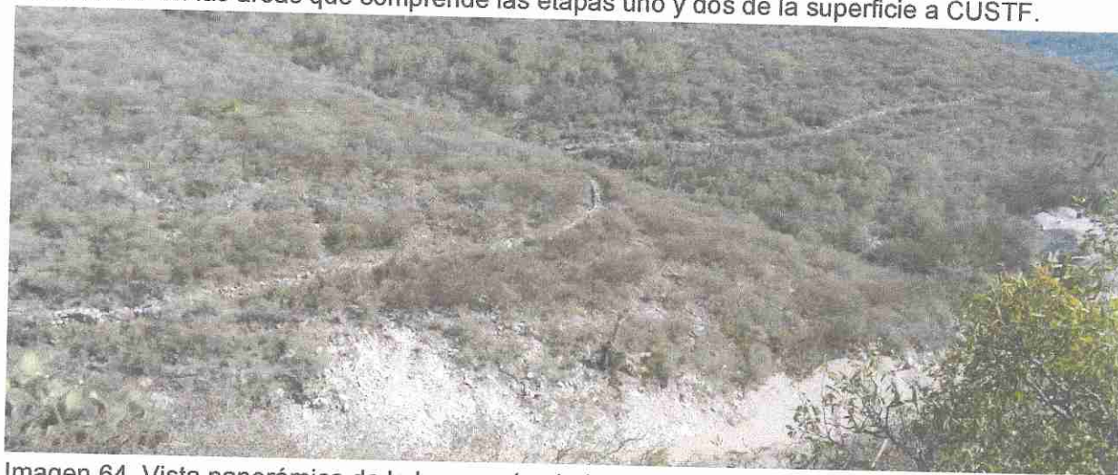
Imagen 64. Vista panorámica de la barrera de piedra acomodada en curva de nivel.
