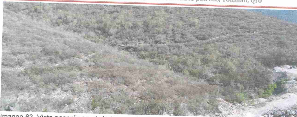
Imagen 63. Vista panorámica de la barrera de piedra acomodada en curva de nivel sobre la cota 1980 msnm en las áreas que comprende las etapas uno y dos de la superficie a CUSTF.
