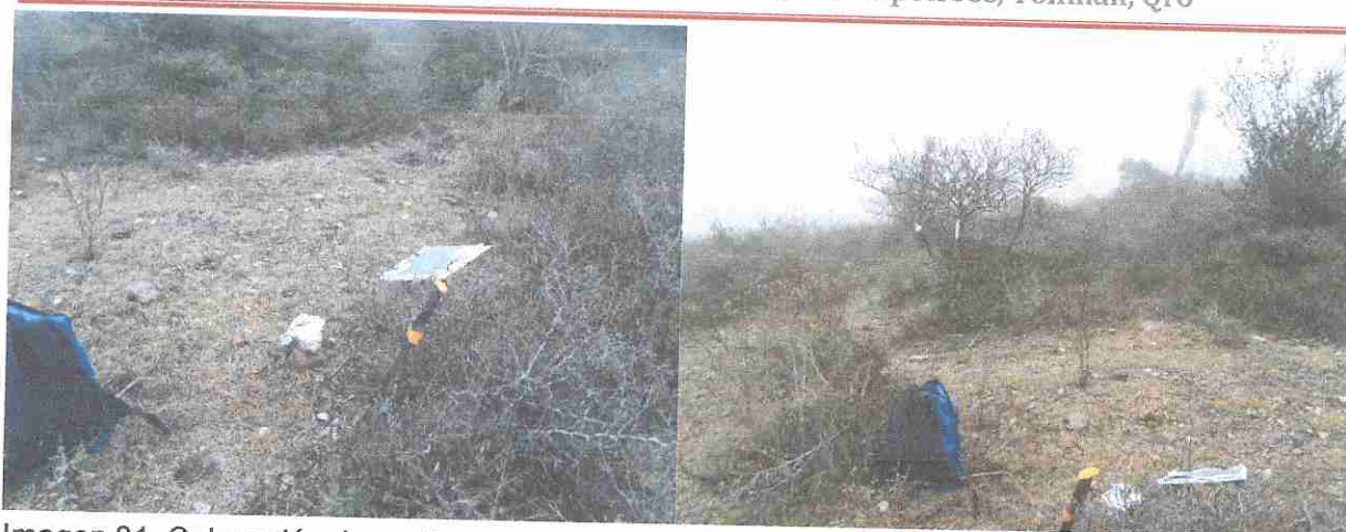
Imagen 81. Colocación de puntos georreferenciados en curvas de nivel donde fueron construidas las tinas ciegas o zanjas trincheras.
