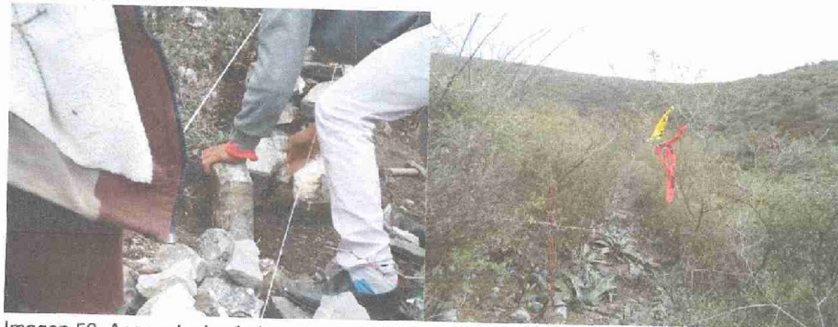
Imagen 59. Acomodo de piedra sobre el trazo que sigue la curva de nivel donde se construye la barrera de piedra acomodada en el área uno y dos de la superficie a CUSTF.
