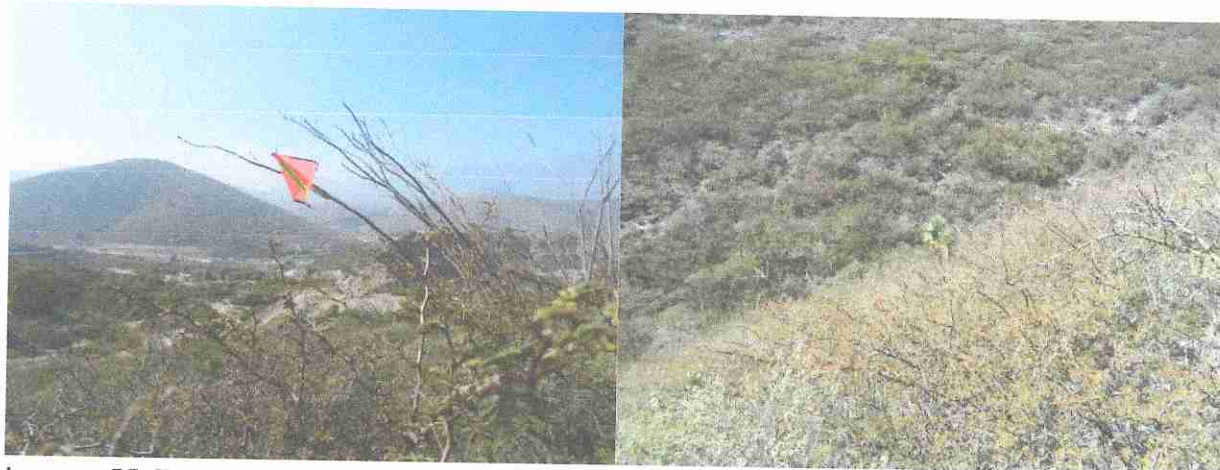
Imagen 55. Trazo, señalización y condiciones generales del área autorizada para cambio de uso de suelo en terrenos forestales donde se construyó la barrera de piedra acomodada.
