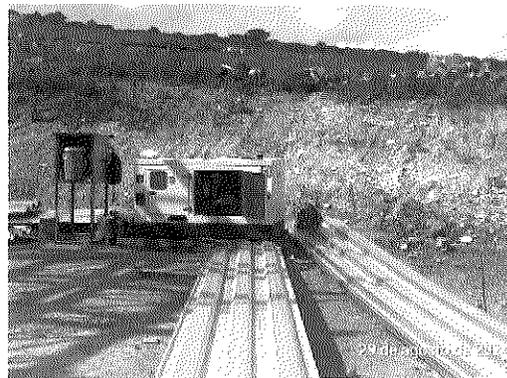
Figuras 348 y 349. Planta eléctrica sobre superficie horizontal y firme de concreto en la zona de campamento.
