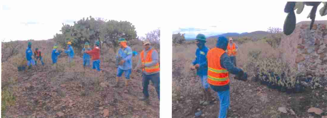
Figuras 131 y 132. Colocación en sitio temporal dentro del predio de Peña Colorada.
