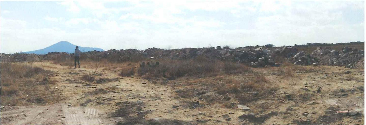
Fotografía 12. Vista del material de despalme y excavación acomodado como barrera temporal
