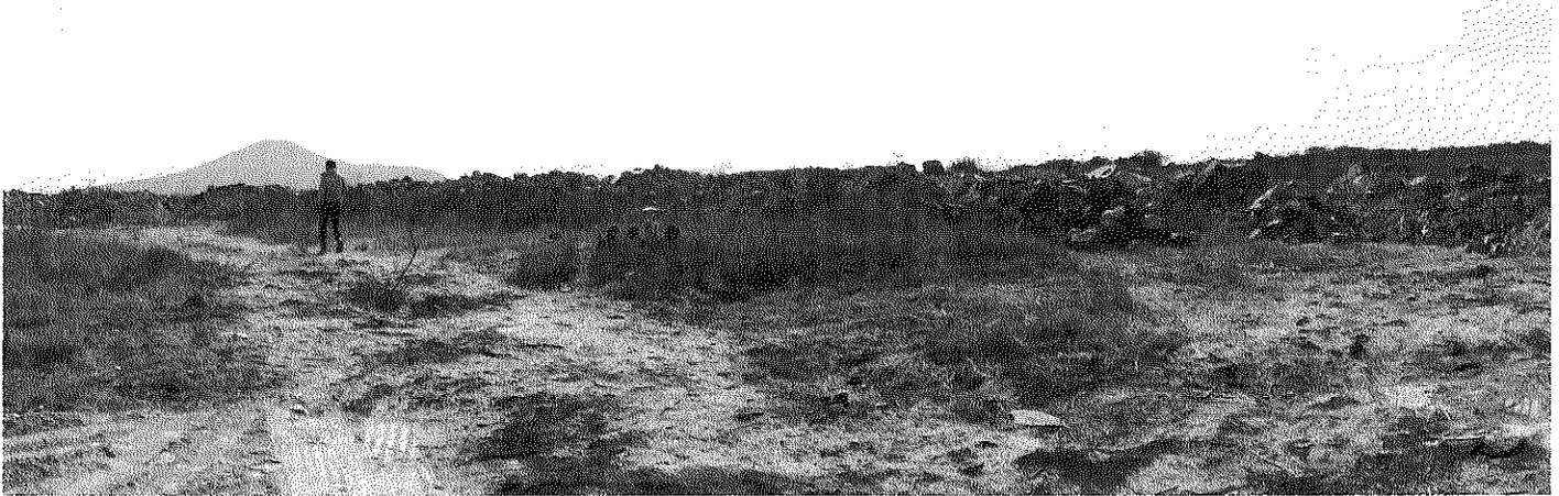
Fotografía 12. Vista del material de despálme y excavación acomodado como barrera temporal.
