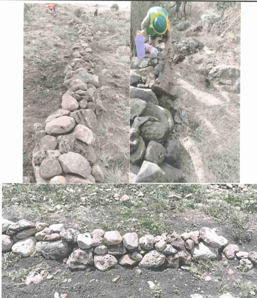
Figura 10. Barreras de piedra acomodada.
