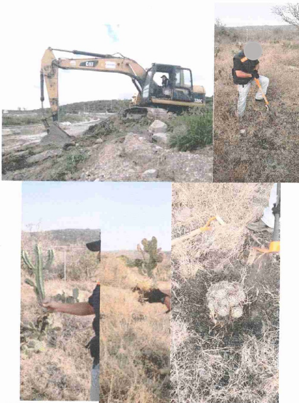
Figura 8. Empleo de maquinaria para el desmonte y rescate manual de especies vegetales.
