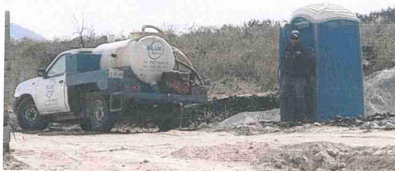
Figura 11. Sanitario y letrinas portátiles.
