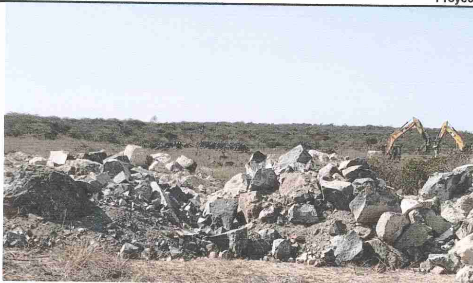
Figura 3. Acomodo de residuos del despalde dentro del predio
