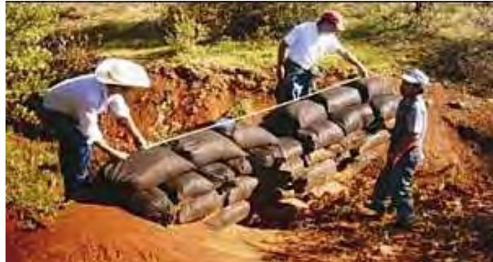
Las presas de costales están constituidas por un muro de bolsas o sacos de rafia, rellenos de tierra, colocados perpendicularmente al flujo de la corriente de agua, para controlar la erosión en cárcavas, reteniendo suelo, rocas u otros fragmentos.
