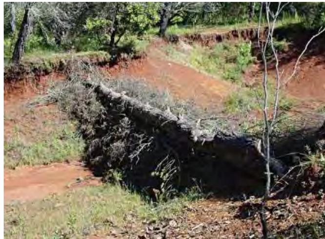
Es una estructura pequeña, construida con ramas entretrejidas, en forma de barreras, que se coloca en sentido transversal a la pendiente, para controlar la erosión en cárcavas.
