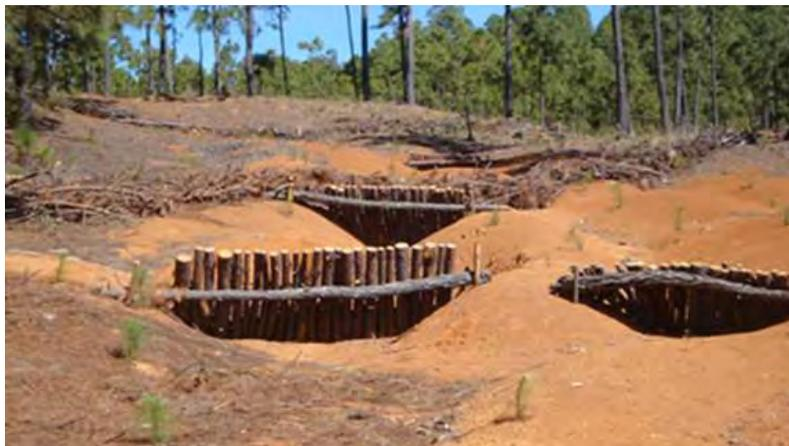
Es una estructura conformada con postes o troncos de diámetros mayores a 10 centímetros. Esta estructura se usa temporalmente y se construye en sentido transversal a la dirección del flujo de corrientes superficiales, en cárcavas pequeñas y angostas, para el control de azolves. Vida útil de 3 a 5 años.
