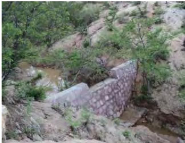
Las presas de mampostería son estructuras permanentes construidas con piedra, arena y cemento, ubicadas de forma transversal a la corriente dentro de un cauce
