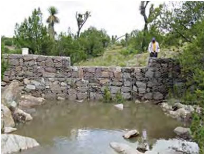
Las presas de gaviones son estructuras permanentes, las cuales se rellenan de piedra con el objeto de formar el cuerpo de la obra que constituye la presa de control. Funcionan como presas filtrantes que permiten el flujo normal del agua y la retención de azolves, son presas flexibles y pueden sufrir deformaciones sin perder eficiencia, debido a que los cajones de gaviones forman una sola estructura.
