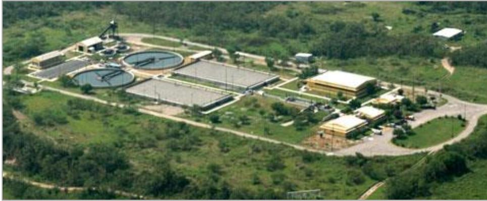
**Figura 5.** Planta de lodos activados en Cd. Acuña, Coahuila.
