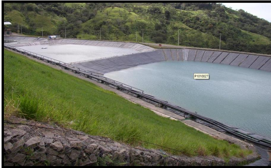
**Figura 9.** Pileta de contingencias y pileta de soluciones del proceso, utilización de geomembranas de doble capa (liner).
