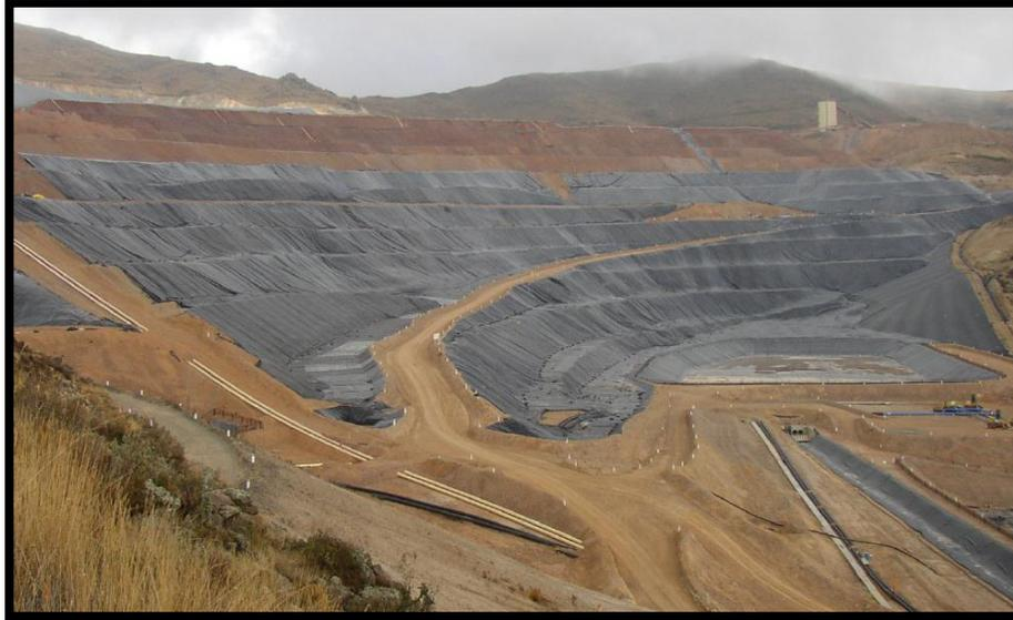
**Figura 10.** Instalación de geomembranas para situaciones de lluvias extraordinarias
