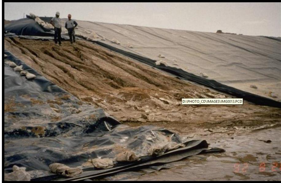
**Figura 12.** Efectos dañinos por carecer de protección de geomembranas adecuadas para lluvias extremas
