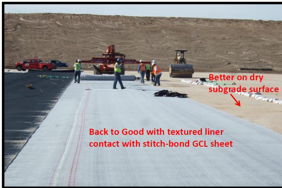
**Figura 14.** Recubrimientos adecuados con capas de arcillas y geomembrana
