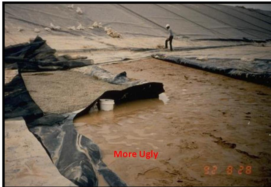
**Figura 13.** Diseño no adecuado de geomembranas para contener los caudales excesivos.
