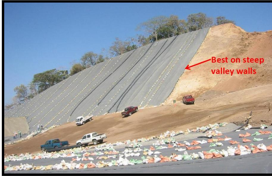
**Figura 15.** Recubrimientos de arcilla y geomembrana adecuados con respecto a la pendiente
