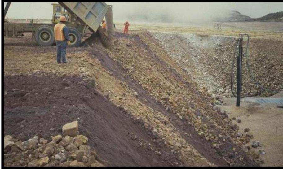
**Figura 6.** Construcción del talud de 30° con respecto a la Norma Internacional establecida, para evitar canalizaciones en caso de lluvias extremas<sup>44</sup>.
