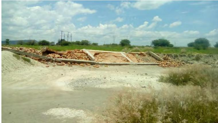
Figura 46. Demolición de barda deteriorada
