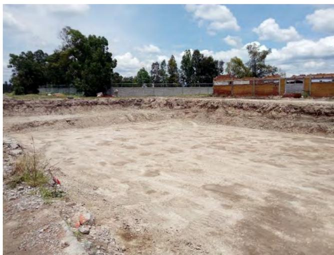
Figura 62. Fin de la excavación de suelo contaminado con mercurio.
