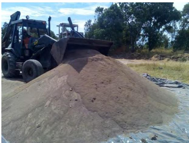
Figura 31. Homogenizado del suelo fino.
