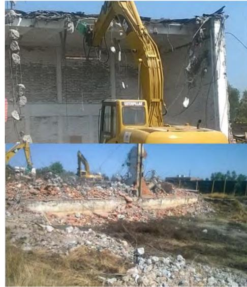
Figura 55. Trabajos de demolición y acarreo de residuos de la planta Sosa-Cloro.
