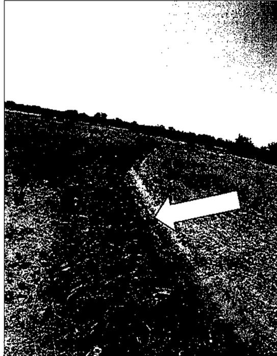
Figura 22. Preparación del terreno para la construcción de zanjas-bordos acorde con el trazo de curvas a nivel con ayuda de tractor como parte de las obras de conservación de suelos; el bordo para retención del agua se coloca pendiente abajo del terreno (la flecha indica la dirección de la pendiente del terreno).
