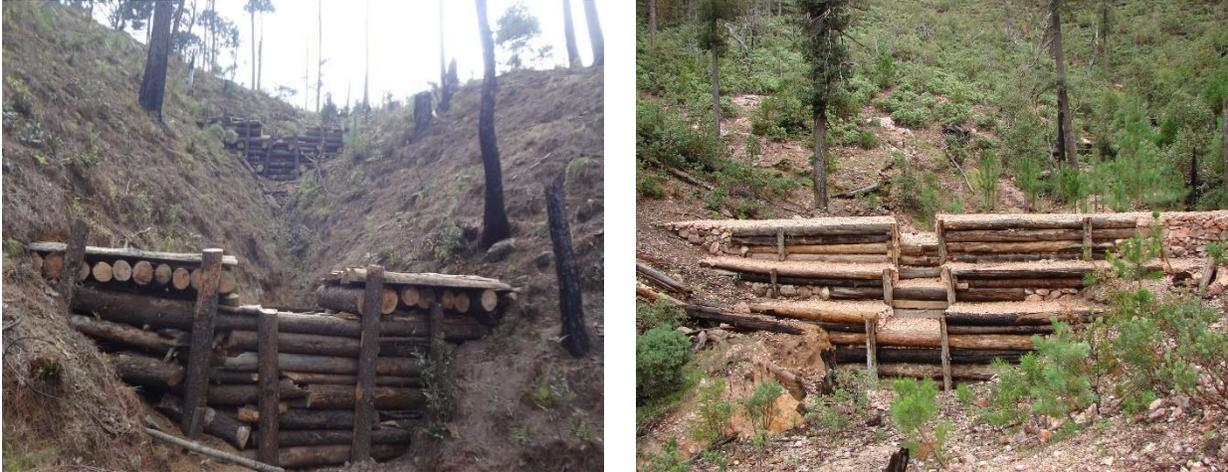
Figura 1. Construcción de presas de morillos.
