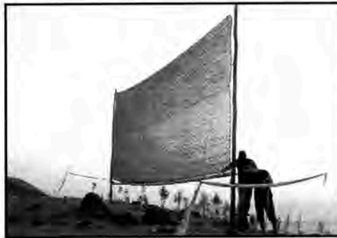
Figura 1. Instalación de red de niebla
