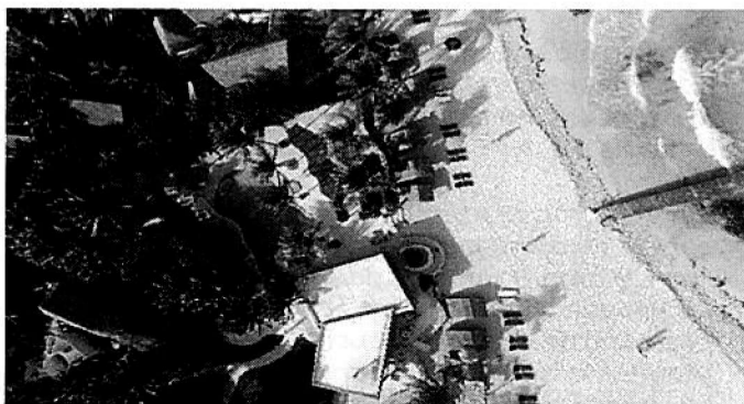
Vista aérea hacia el sitio de desplante inicial del muelle, se observa sin vegetación.
