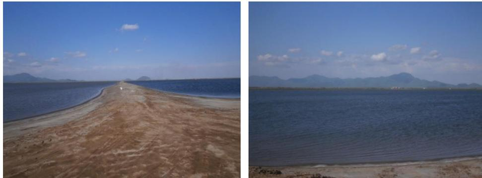
La forma de los estanques es rectangular, con bordos trapezoidales en donde el talud por lo general es 2:1. Esta forma se describe en la figura siguiente:
