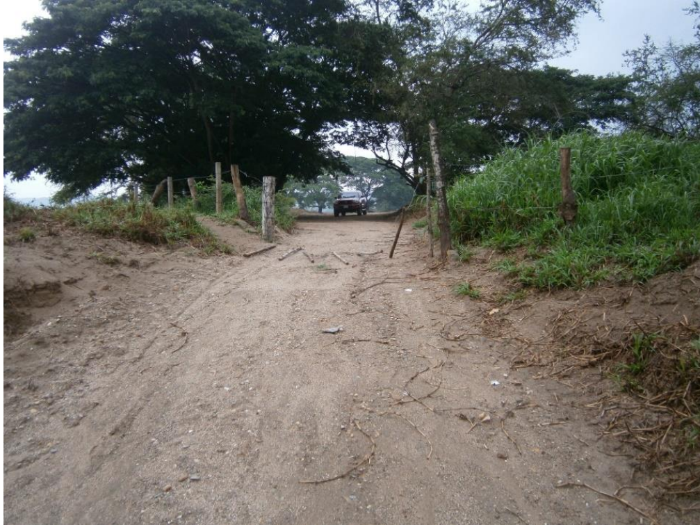
Fotografía 5. Rampa de acceso al banco de extracción.
