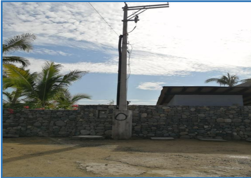
Ilustración 28. En esta imagen se pueden observar que ya se cuenta con servicio eléctrico en la zona.
