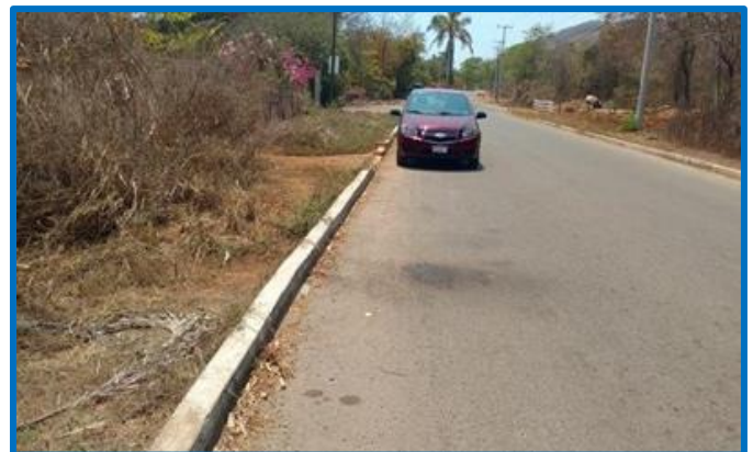
Vista 2 Foto 2.- Vista del camino local pavimentado de la localidad Emiliano Zapata.
