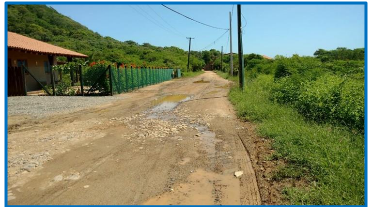
Foto 6.- Vista este de camino de terracería
